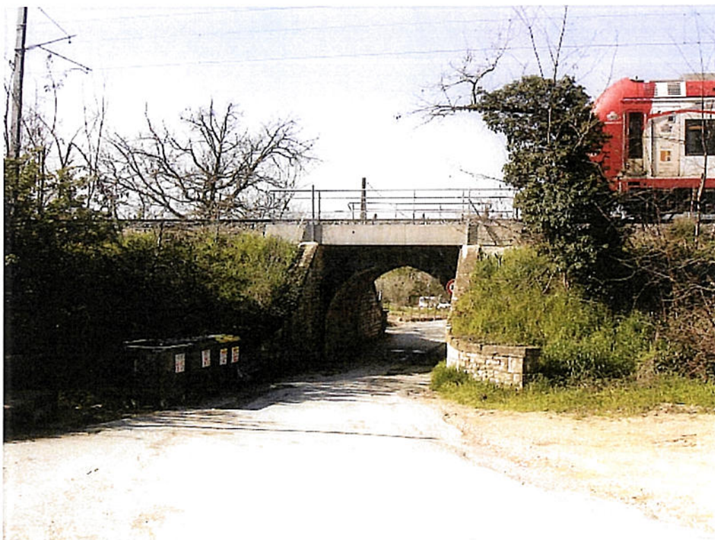
Photo 2 : Pont rail actuel – 2011
