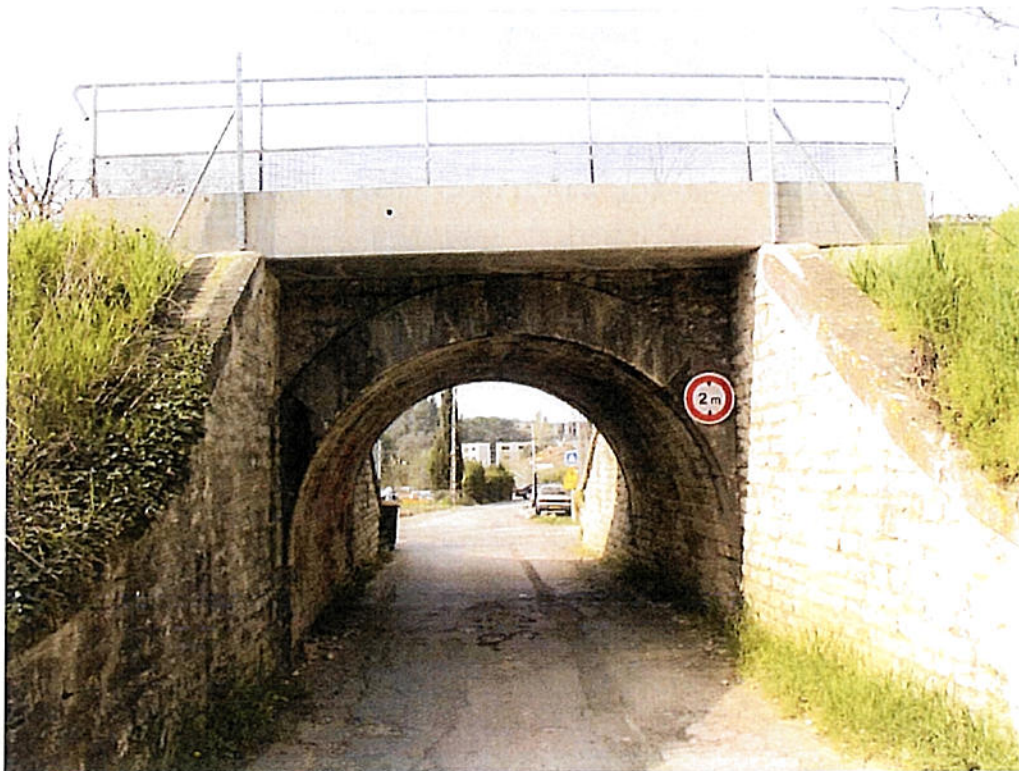
Photo 1 : Pont rail actuel – 2011
