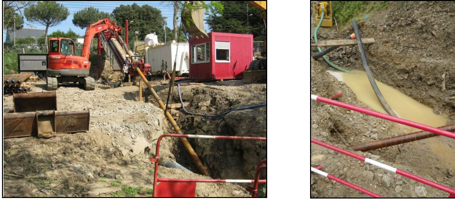
Figure 5. Atelier de forage dirigé (ERDF, 2013)
