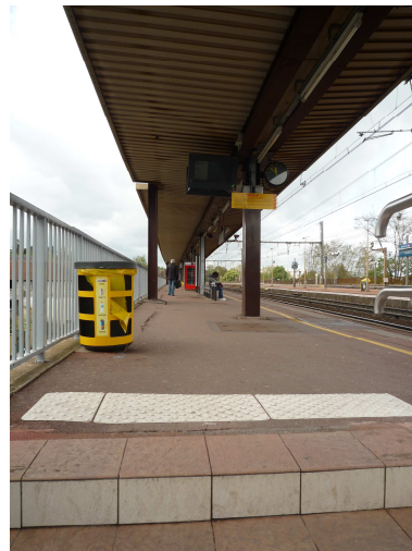
- Photo N4 : Dernière contremarche des Escaliers Fixes 4 et quai 3 -
