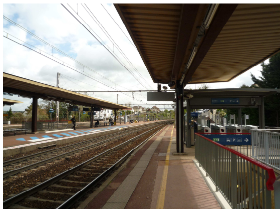
- Photo N7 : Quai 3 en direction de la Province - (Projet : Mise en place du futur ascenseur)
