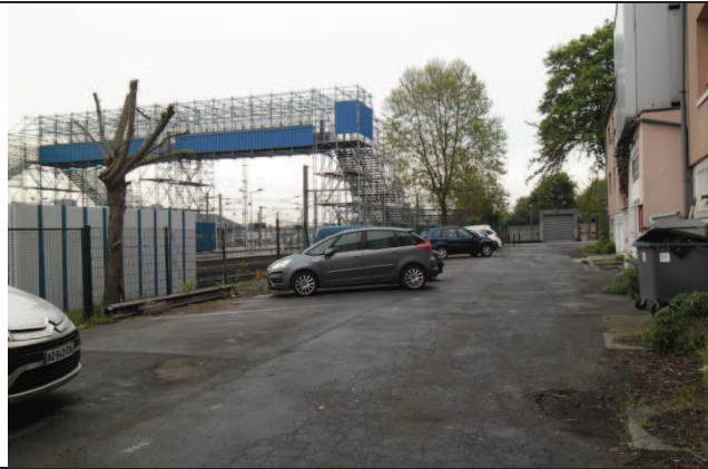
Image n°7 : Parking SNCF qui sera partiellement utilisée pour la circulation des engins de chantier
