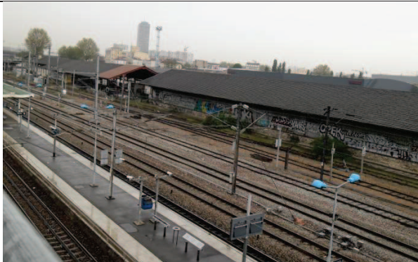
Image J : Bâtiments industriels au nord de la gare
