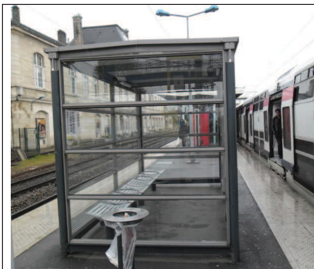
Image n°13 : Abri couvert qui sera démonté – Quai 1
