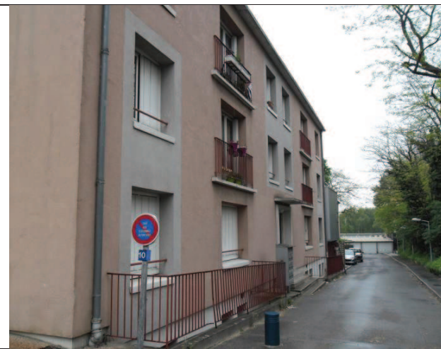
Image n°9 : Voie d'accès aux installations de chantier
