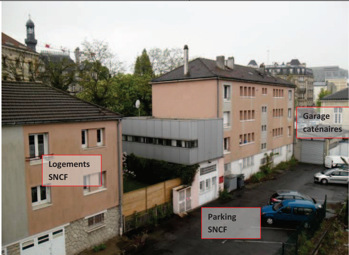
Image I : Logements et parking SNCF qui seront utilisés pour les installations de chantier
