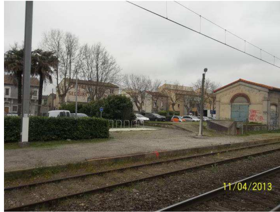
Figure 3 : Vue depuis le quai central vers l'ouest, 11/04/2013
