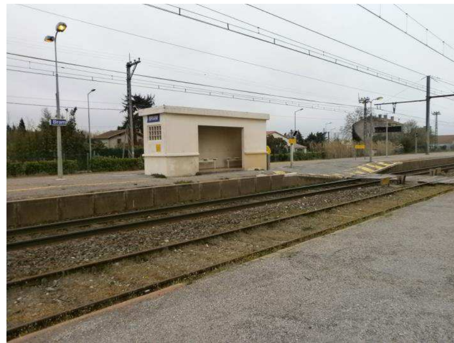
Figure 4 : Vue depuis le quai n°1 vers l'est, 11/04/2013
