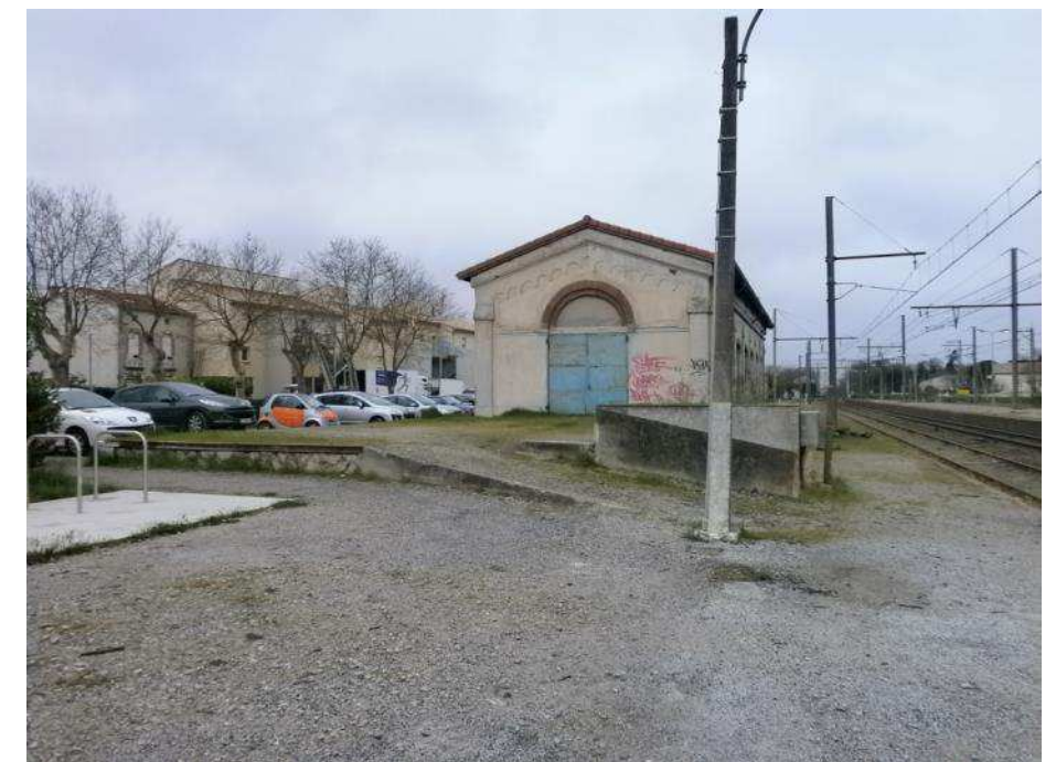
Figure 6 : Vue du site d'implantation de la passerelle sur le quai n°1, 11/04/2013
