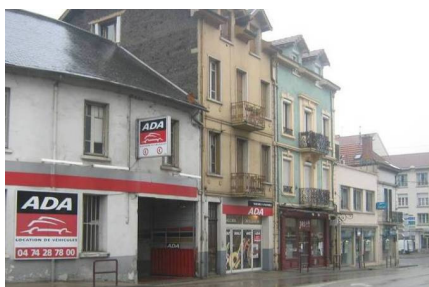
Figure 6 : Immeubles mixtes de la RD 522, au Nord de la gare (fevrier2012)
