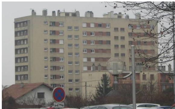
Figure 4 : photo d'immeuble de l'Avenue des Alpes (RD 1006) (fevrier2012)
