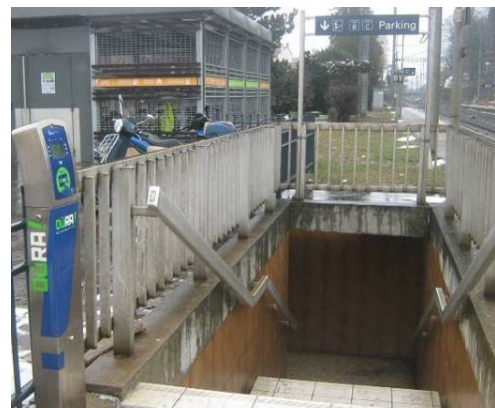
Figure 8 : Escalier Nord (quai 1) connecté au passage souterrain (février 2012)
