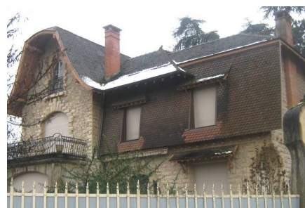
Figure 5 : logement pavillonnaire, avenue des Alpes (RD 1006), en face de la Halle des sports (fevrier2012)
