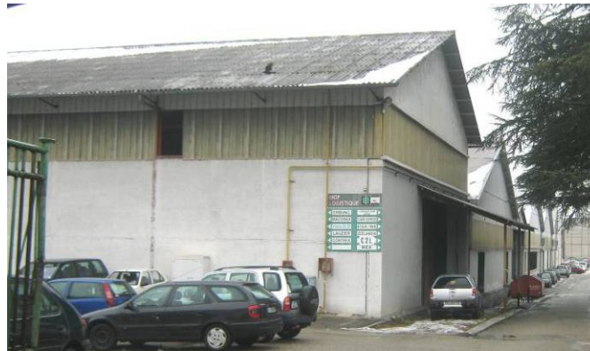
Figure 7 : entrepôts de logistique, au Sud de la gare (février 2012)
