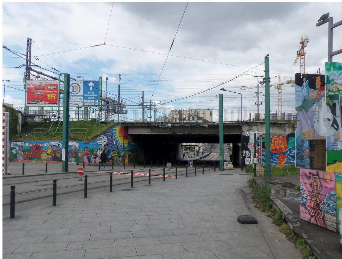
05a_Rue du port, à l'est de la gare, vue vers l'ouest, vers le pont-rail
