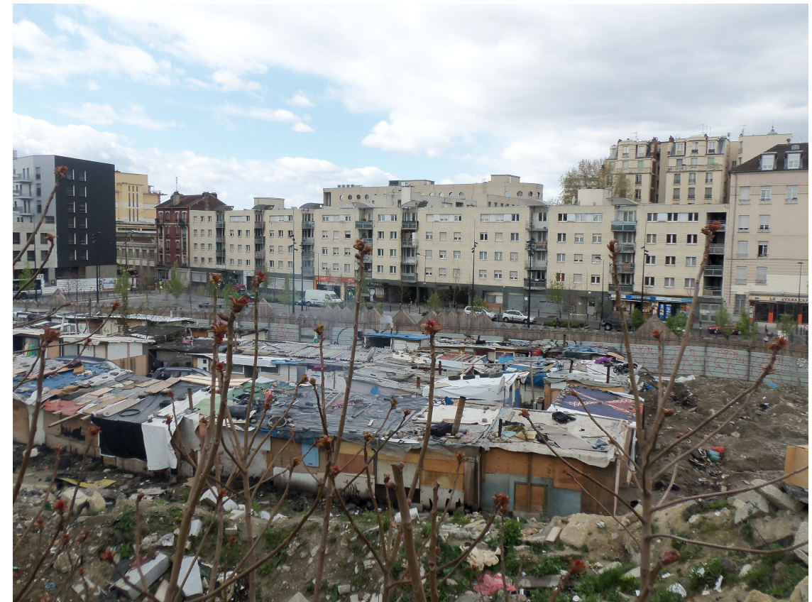
10c_Gare de Saint-Denis, vue depuis le nord du quai 5, vue vers l'ouest sur le camp installé
