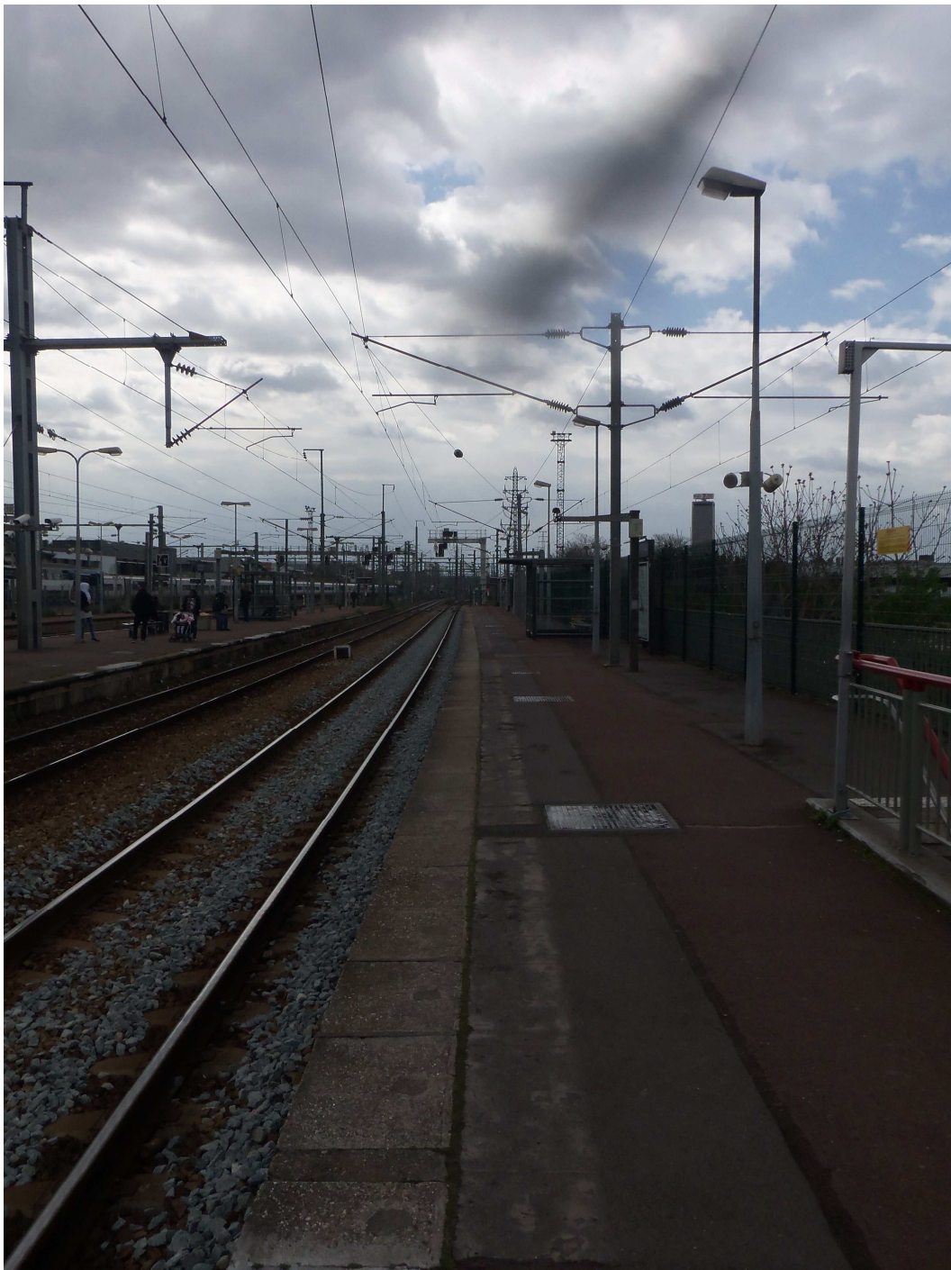
09b_Gare de Saint-Denis, vue depuis le sud du quai 5 vers le sud
