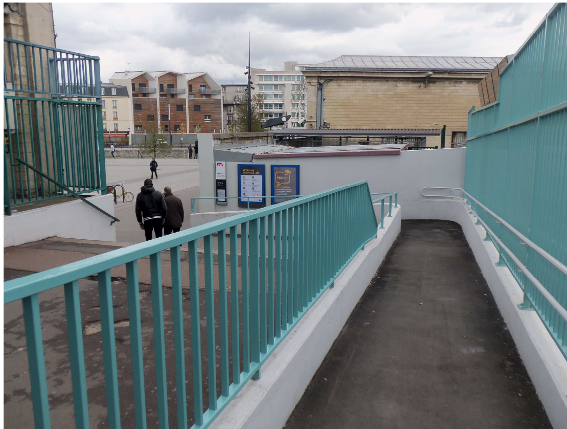
14a_Sortie depuis le quai 1, depuis le passage souterrain sud n°3, accès PMR
