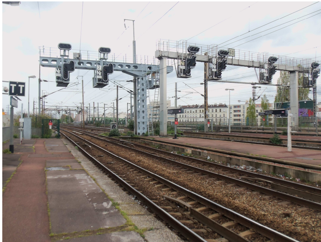
10a_Gare de Saint-Denis, vue depuis le nord du quai 5, vue vers le nord sur les voies ferrées
