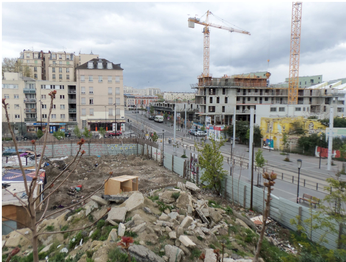
10b_Gare de Saint-Denis, vue depuis le nord du quai 5, vue vers le nord-ouest sur le chantier
