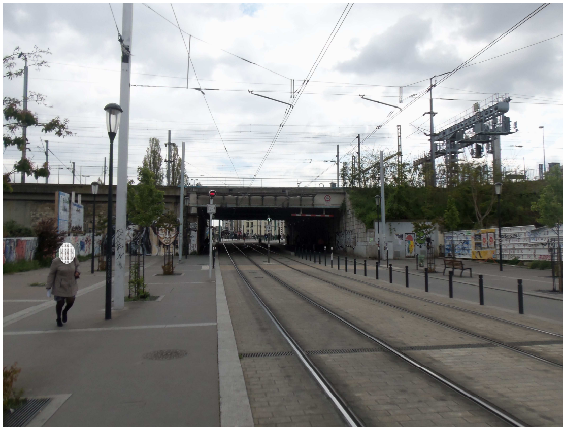
06b_Rue du port, à l'ouest de la gare, vue vers le pont-rail, vue vers l'est
