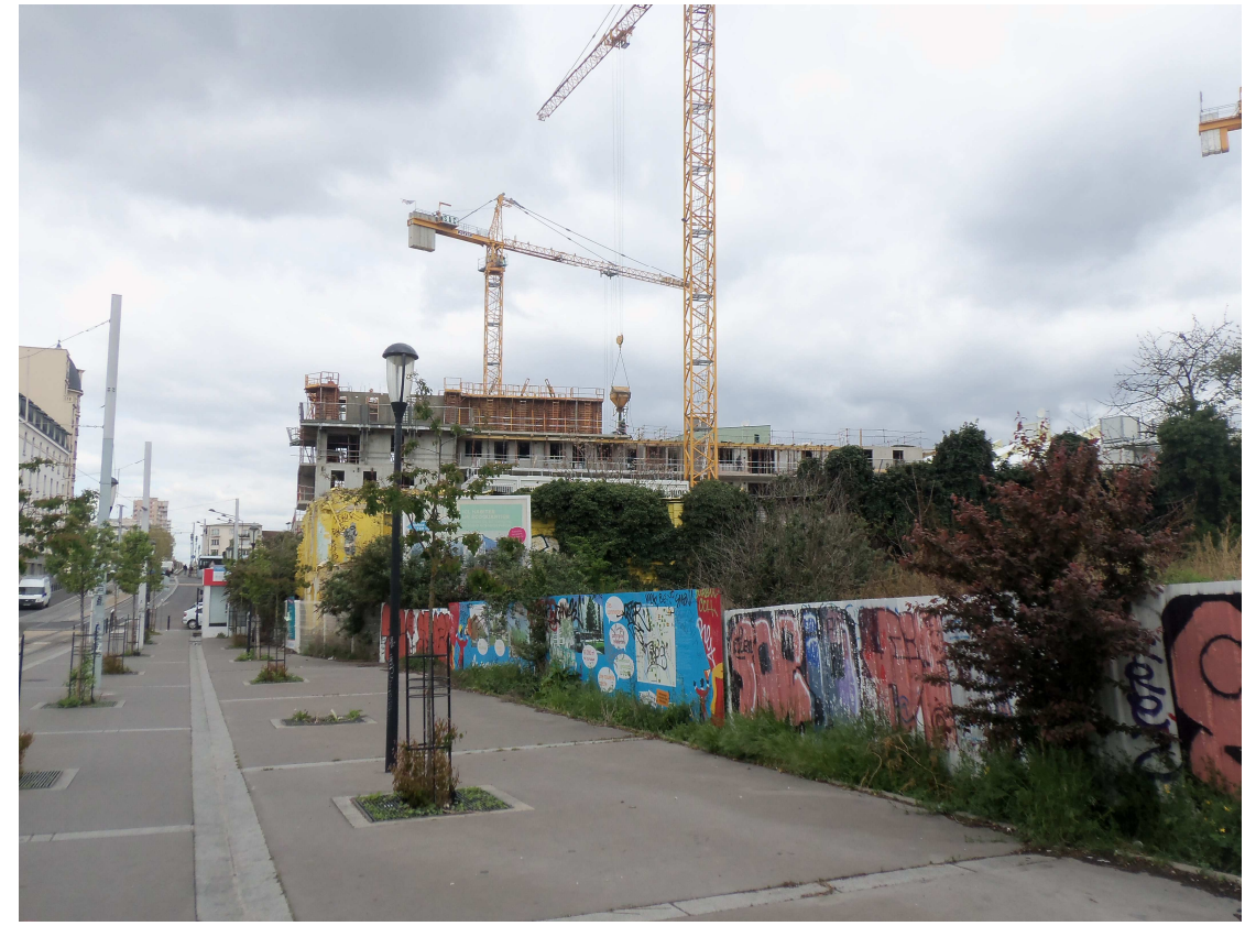
06a_Rue du port, à l'ouest de la gare, vue sur le chantier au nord-ouest des voies ferrées
