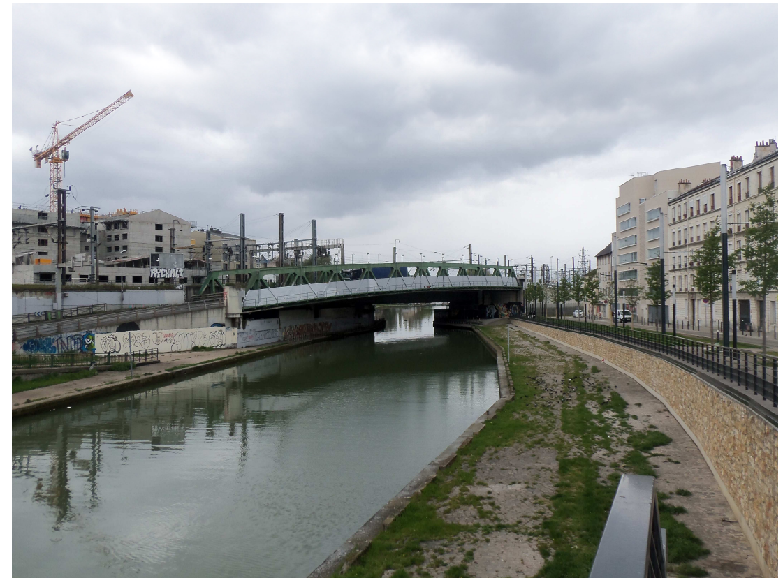
15a_Vue depuis la station de tramway T1, vue vers le nord, canal et rue Brise-Echalas
