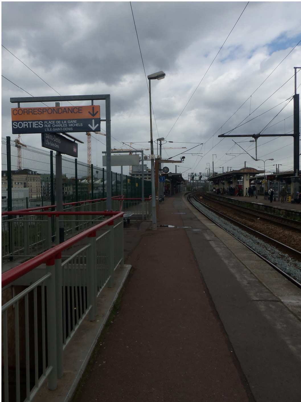
09a_Gare de Saint-Denis, vue depuis le sud du quai 5 vers le nord
