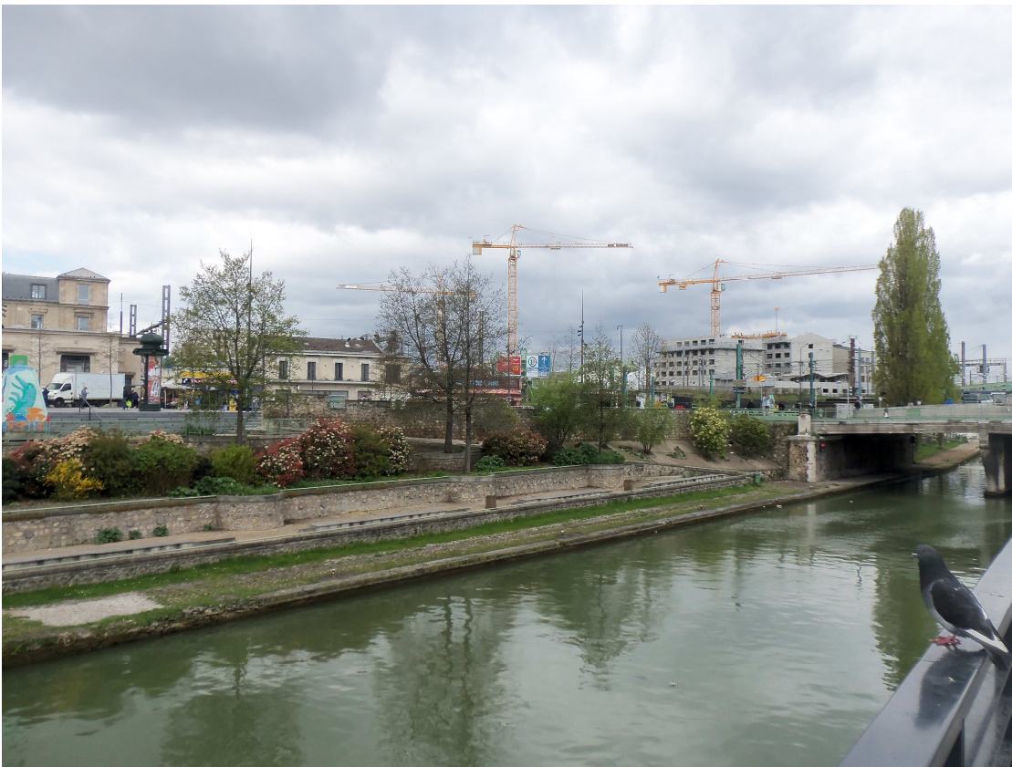
01b_Gare et chantier vus depuis la station de Tramway T8, avec canal au premier plan (vue vers le nord-ouest)
