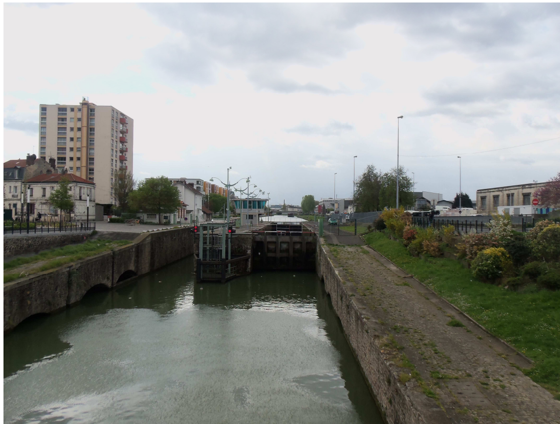
02b_Vue vers le sud depuis la passerelle piétonne sur le canal
