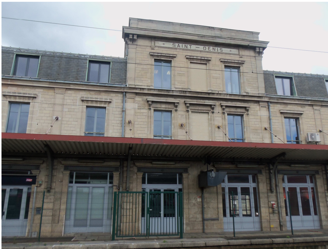
12_Bâtiment voyageur vu depuis le quai 2 (vue vers l'est)
