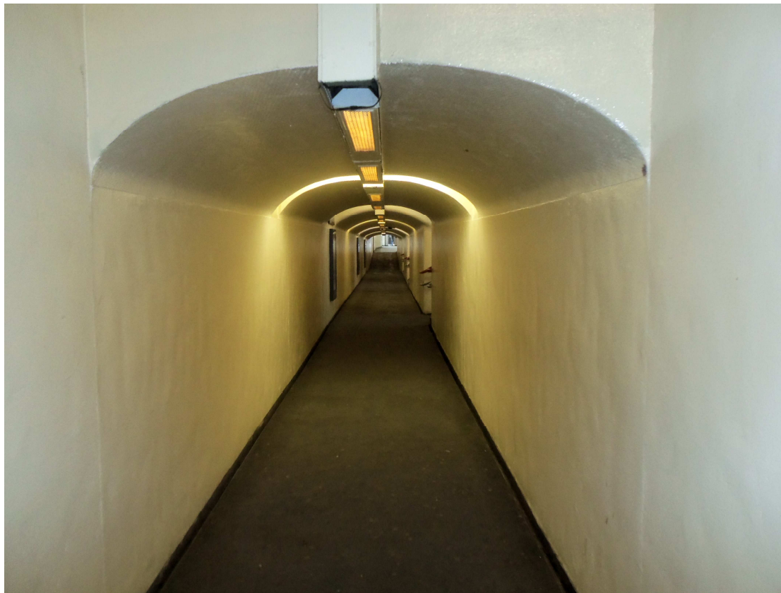
11_Passage souterrain nord n°2, vue vers l'est
