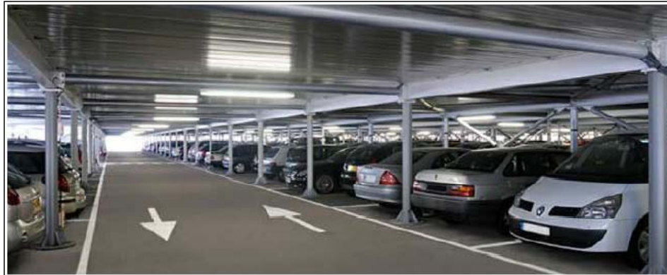
Vue intérieure d'un parking_image de référence
