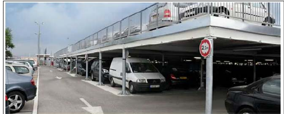
Façade extérieur d'un parking_image de référence
