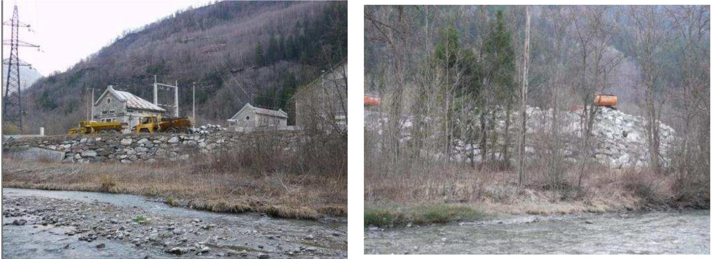
Photo 11 : Protections en rive gauche du pont de Viclaire.
