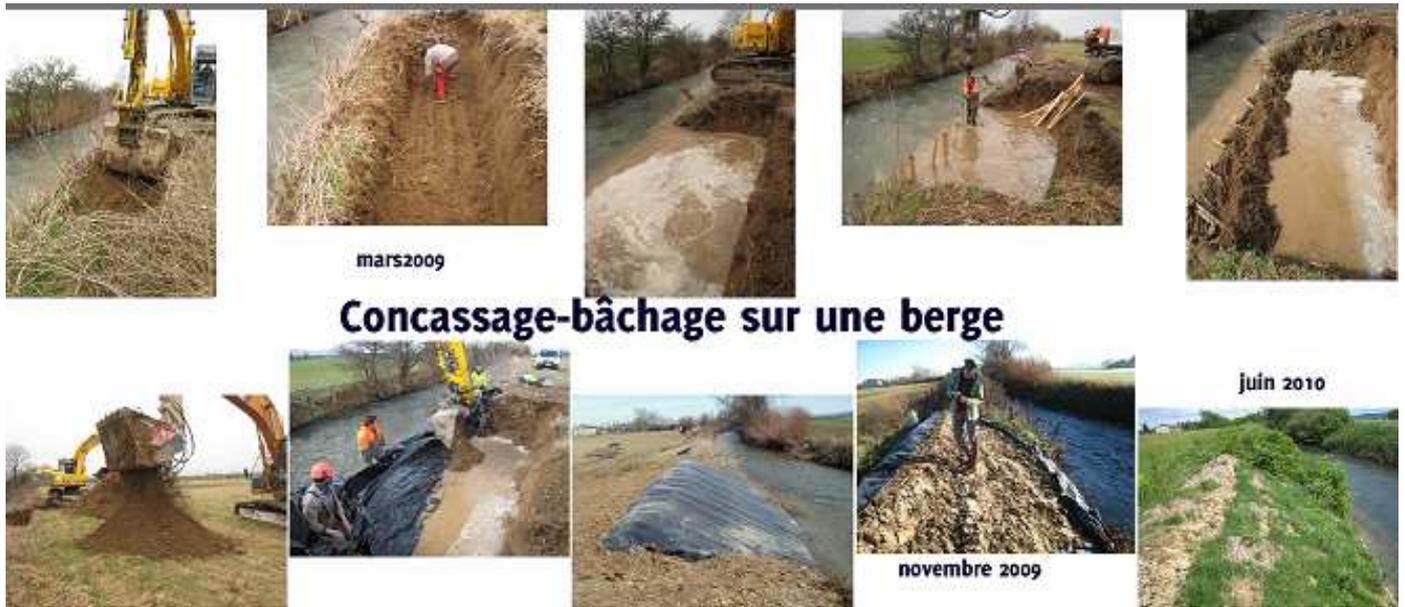
Figure 11 : Chantier expérimental d'éradication mécanique par concassage bâchage sur une berge (2010)
