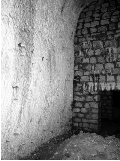
photo 15: vue d'un pilier et des consolidations sous le bâtiment 16 route de Louveciennes
