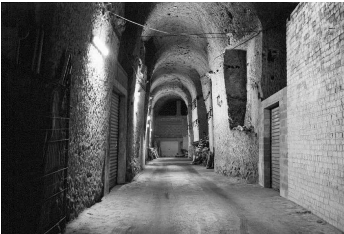
photo 19: galeries au niveau du 12 avenue de la Drionne
