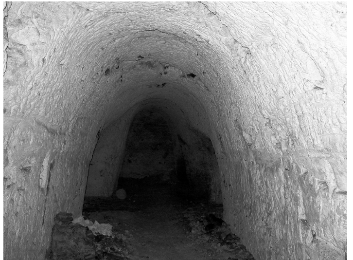
photo 18:Galerie dans la craie
