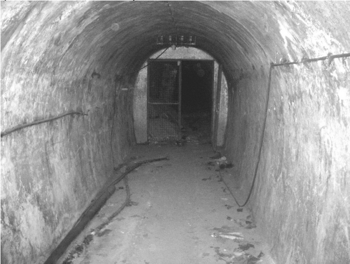
photo 13: Vue de la galerie d'accès de la carrière
