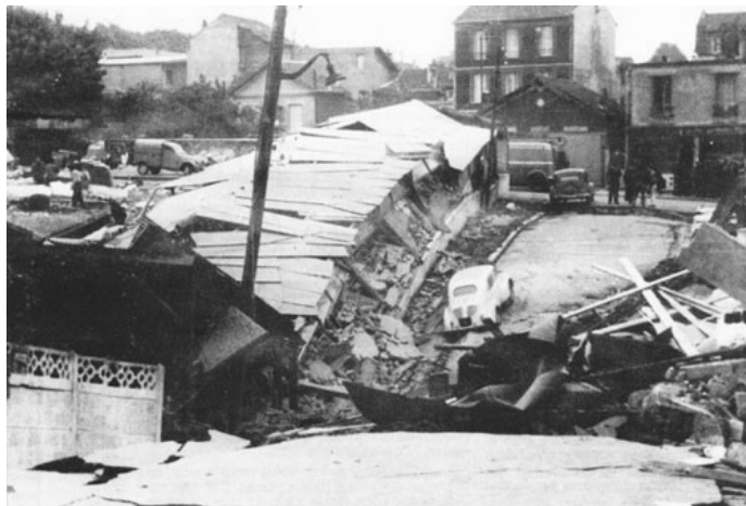
photo 28: Conséquences de l'effondrement généralisé de carrières de craie et de calcaire grossier à Clamart (92) en 1961 Etat des infrastructures routières et du bâti au droit des zones effondrées Origine des photos: M. Toulemont (M.A.T.E)
