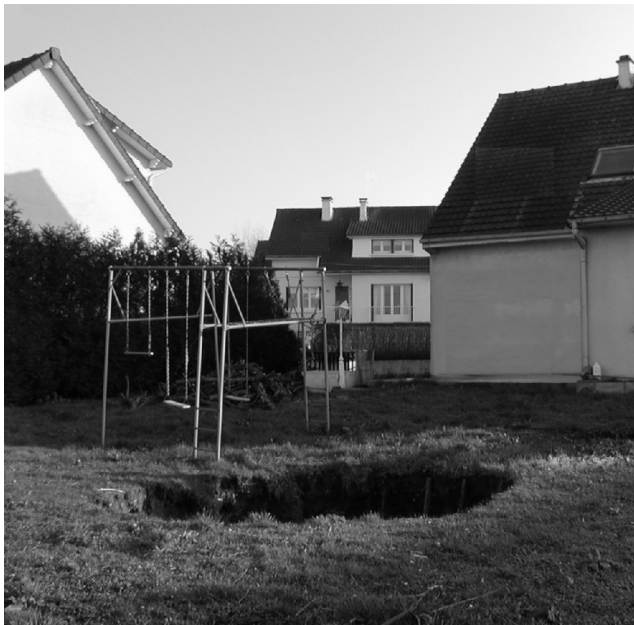
photo 27: Fontis venue à jour dans une zone pavillonnaire
