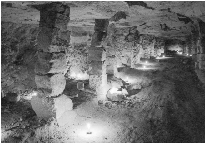
photo 5: Galerie avec piliers à bras
