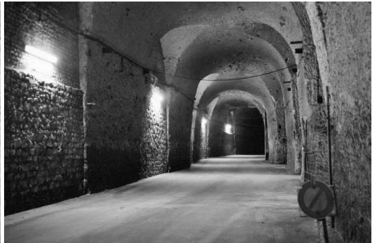
photo 20: galeries au niveau du 12 avenue de la Drionne
