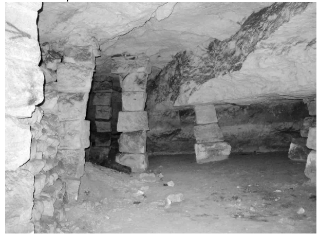
photo 10: vue des galeries avec piliers à bras
