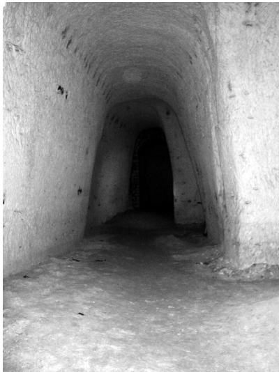
photo 17:Galerie dans la craie
