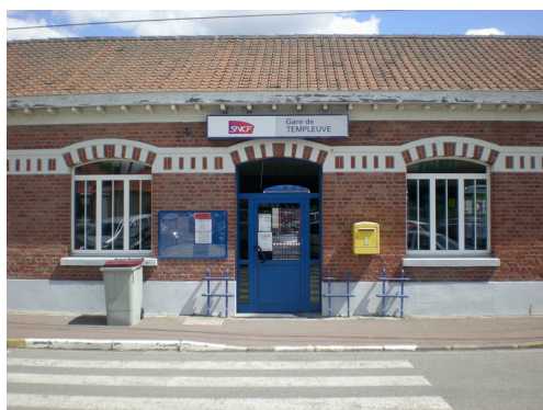
La gare de Templeuve - L'entrée en façade
