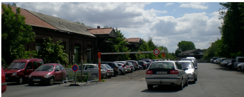
Stationnement existant au droit de l'entrepot
