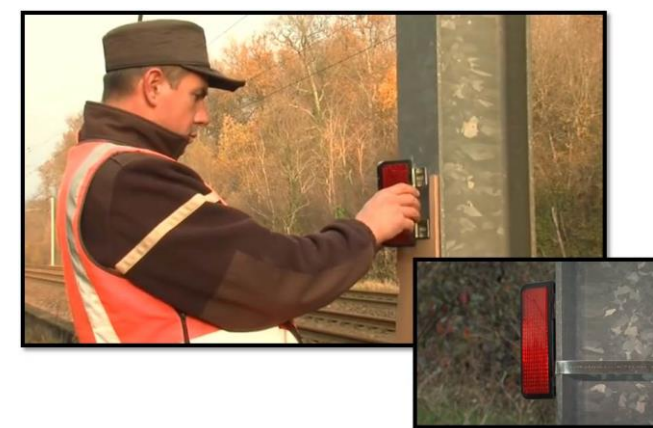
Illustration de catadioptrés installés sur des caténaires en bord de voie ferrée (source : SNCF)
