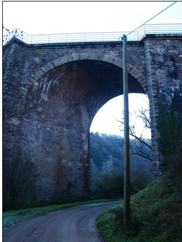
Photo 5 : Viaduc situé sur l'ENS des Corbinières
