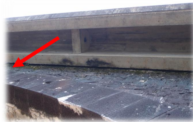
Photo 9 : Espace entre le pont et la corniche favorable pour les chauves-souris
