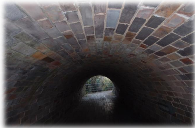
Photo 7 : Pont parfaitement jointoyé, non favorable pour les chauves-souris
