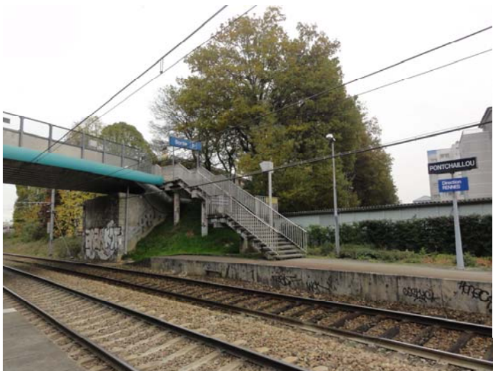
Escalier Sud de la halte ferroviaire
