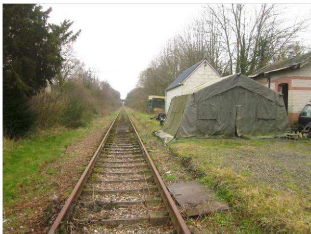
Ancien quai, au droit du Bâtiment voyageurs
