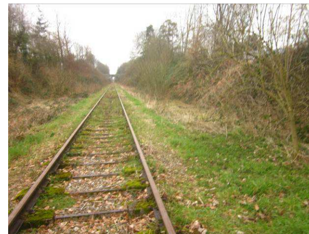
Photo prise à l'extrémité du quai existant ; le quai prendra place entre le talus et la voie
