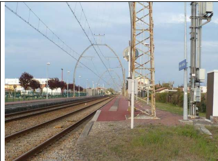
Photo 11 : Extrémité quai n°1 - côté Arcachon
