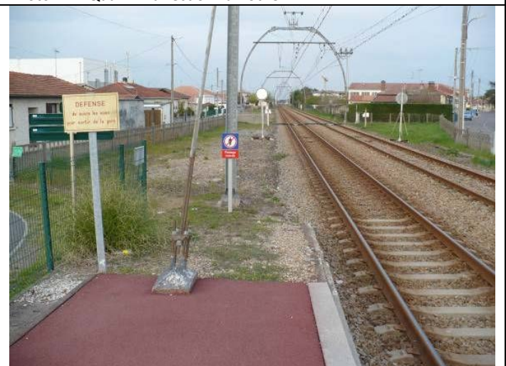
Photo 16 – Extrémité quai n°2 direction Lamothe
