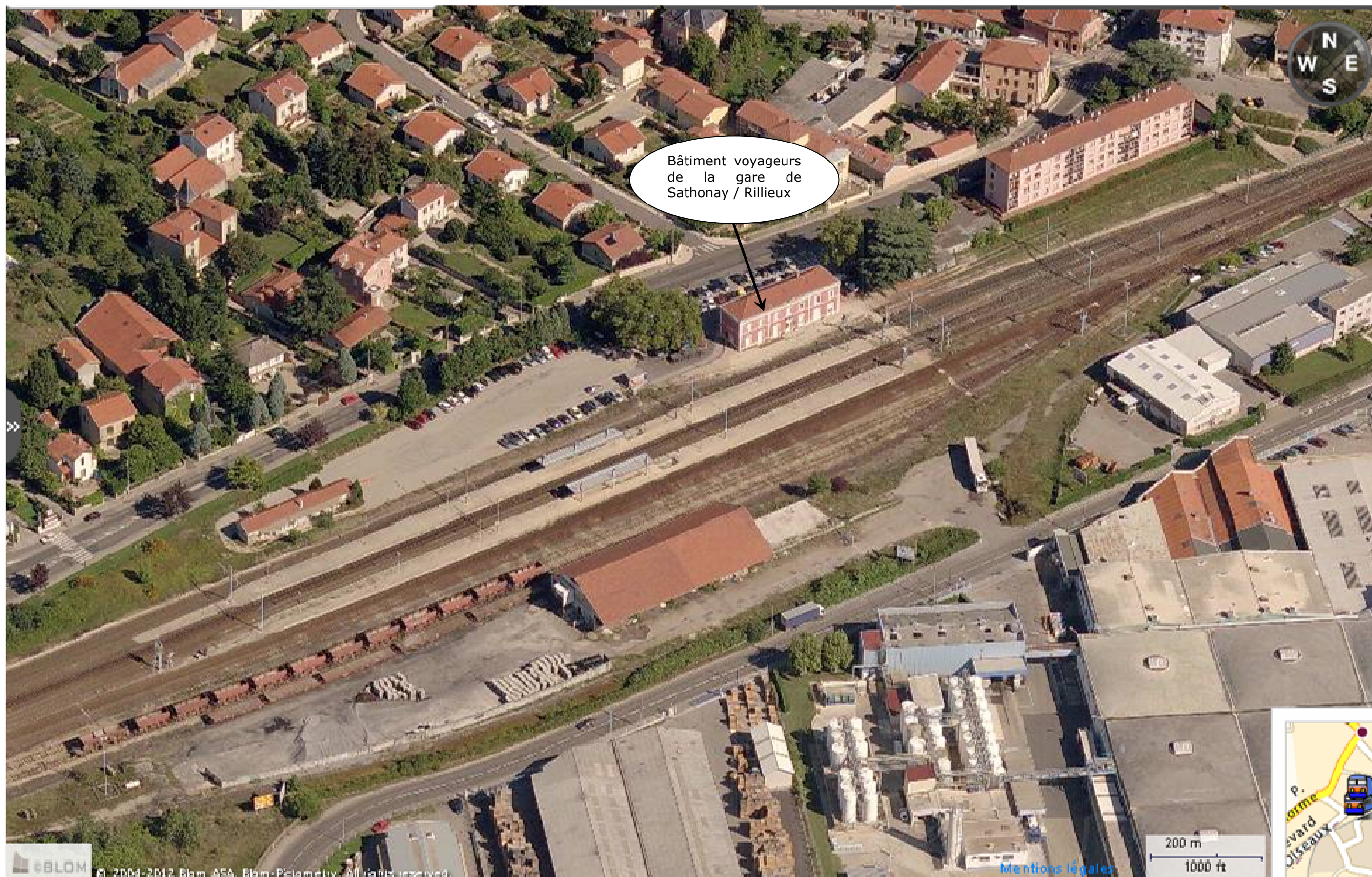
Figure 3 : Vue aérienne du secteur de la gare de Sathonay / Rillieux Source : Via Michelin - 2004
