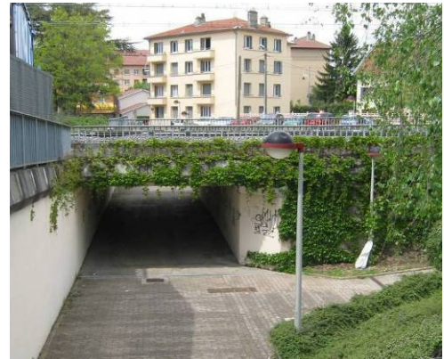
Figure 16 : Prise de vue depuis le Sud du passage souterrain piétons situé à l'Est de la gare
