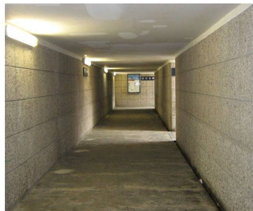
Figure 18 : Prise de vue du passage souterrain de la gare de Sathonay / Rillieux
