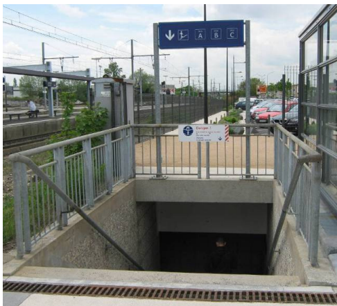
Figure 17 : Prise de vue de l'entrée du passage souterrain de la gare de Sathonay / Rillieux côté bâtiment voyageurs
