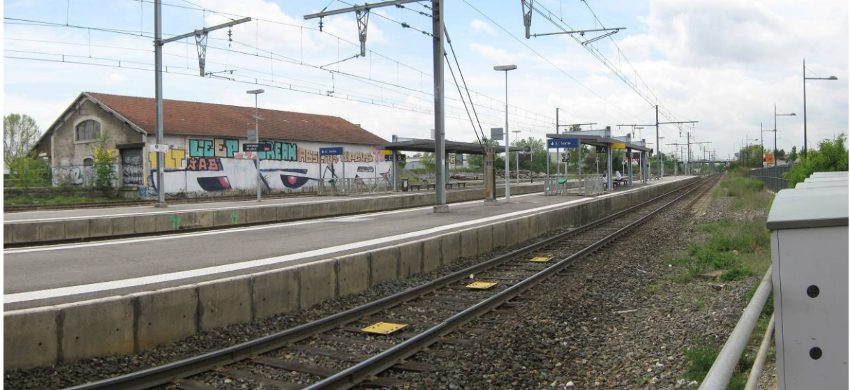
Figure 21 : Prise de vue depuis le bâtiment voyageur en direction des quais
