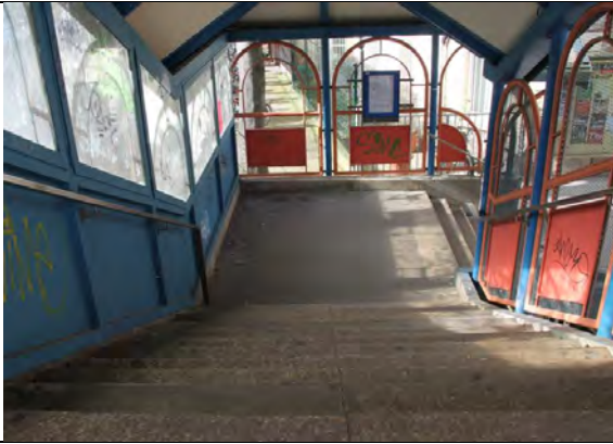
Image n°13 : Sortie de la passerelle, côté Bois-Colombes
