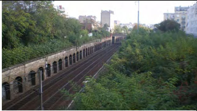
Image A : Vue lointaine de la passerelle couverte de la gare des Vallées
