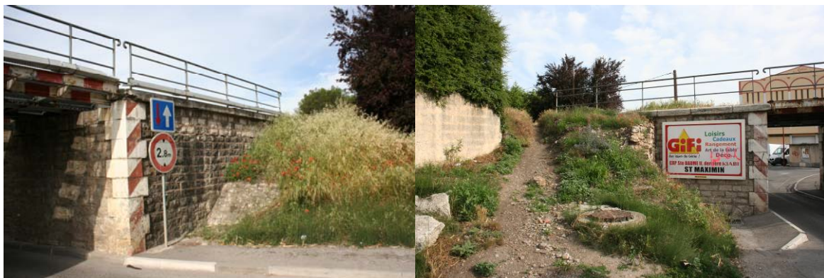
Illustration des talus Nord à gauche et Sud à droite
