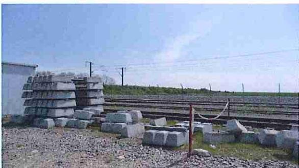
Image n°7 : Stockage actuel des traverses de béton
