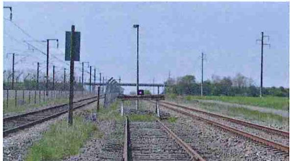
Image n°6 : Butoir de la voie R3, emplacement du nouveau raccordement des voies R3 et R5 avec la communication 105/106 déposée par ailleurs et de la création du nouveau tiroir de manœuvre (vue direction Sud-Ouest)
