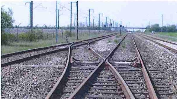
Image n°5 : Communication 105/106 à déposer (vue direction Sud-Ouest)
