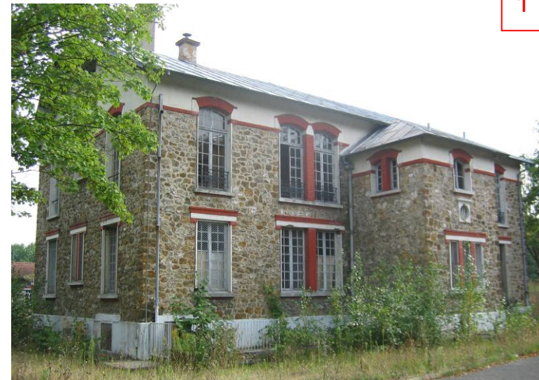
Façades avant et arrière du bâtiment de commandement
