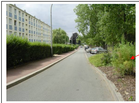
Une bordure paysagère à requalifier et une offre de stationnement en épis.
