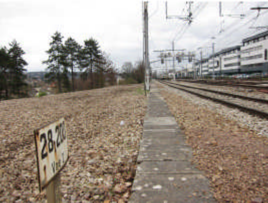
Vue 9 : Vue de la zone voie 2
