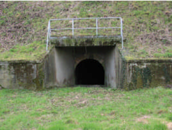
Vue 11 : Ponceau de Mondétour
