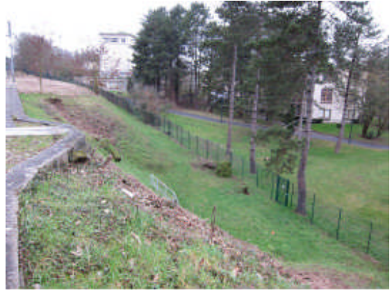
Vue 10 : Talus en remblai côté Ponceau de Mondétour
