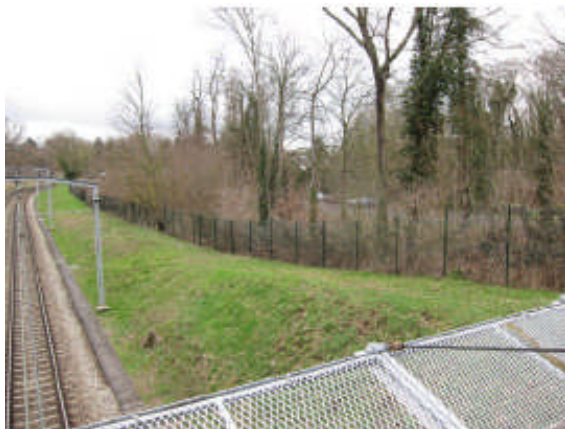
Vue 3 : Abords du Pont – Zone fiches Nord
