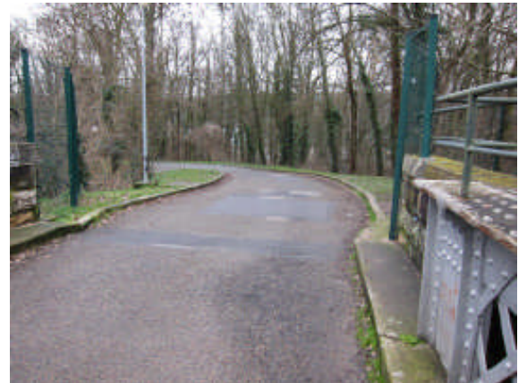
Vue 4 : Abords du Pont – voirie Zone Nord
