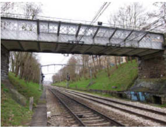
Vue 1 : Pont du Grand Mesnil
