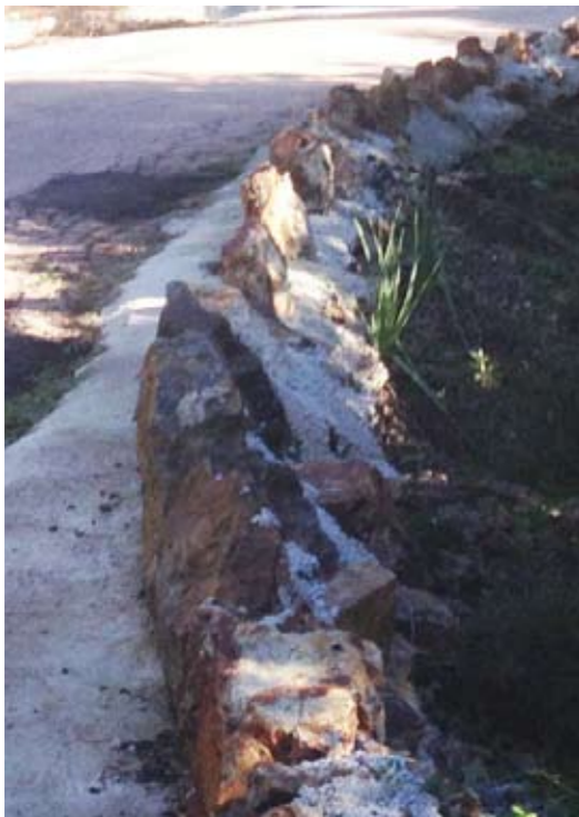
Pierres dressées maçonnées
