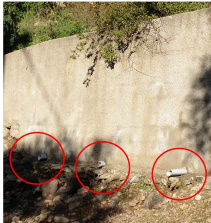
Soutènement en béton et barbacanes en pvc
