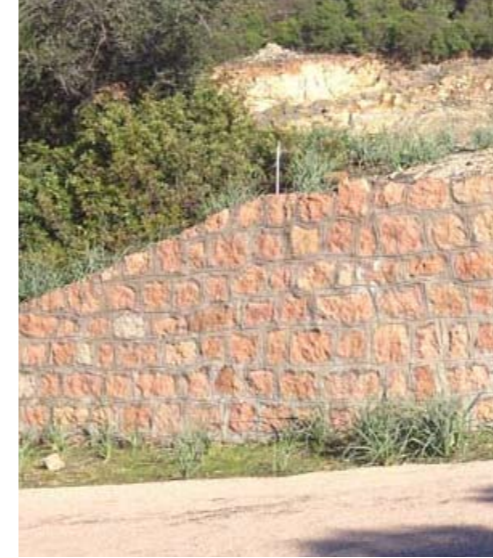
Mur de soutènement en pierres
