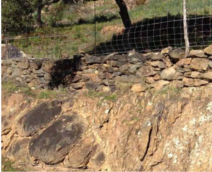
Muret en pierres épousant le talus rocheux
