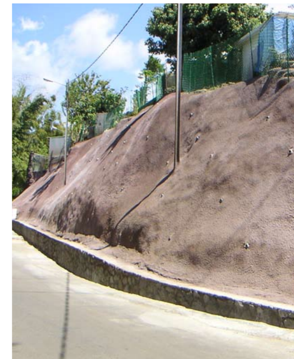
Béton projeté sur talus
