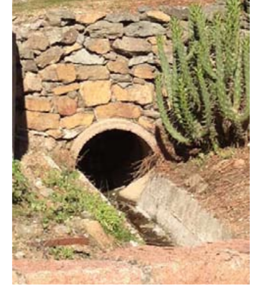
Soutènement en pierres sur buse
