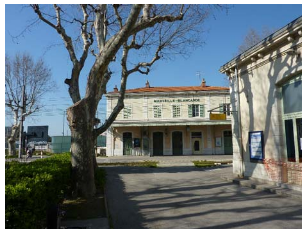
05 - accès BV côté bâtiment annexe
