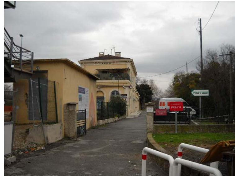
1 - Accès au BV
