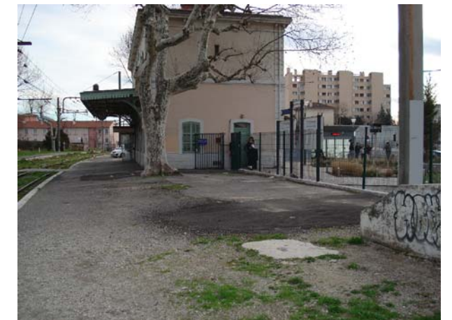
04 - pignon nord côté BV
