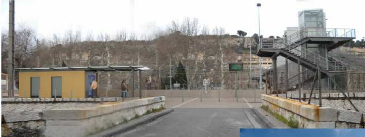
vue sur SAS-abri
