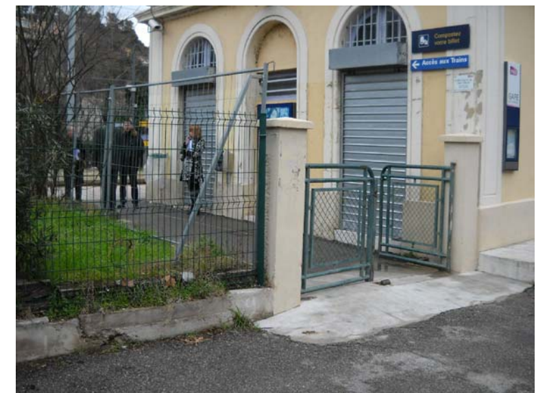
5 - Accès au quai côté BV
