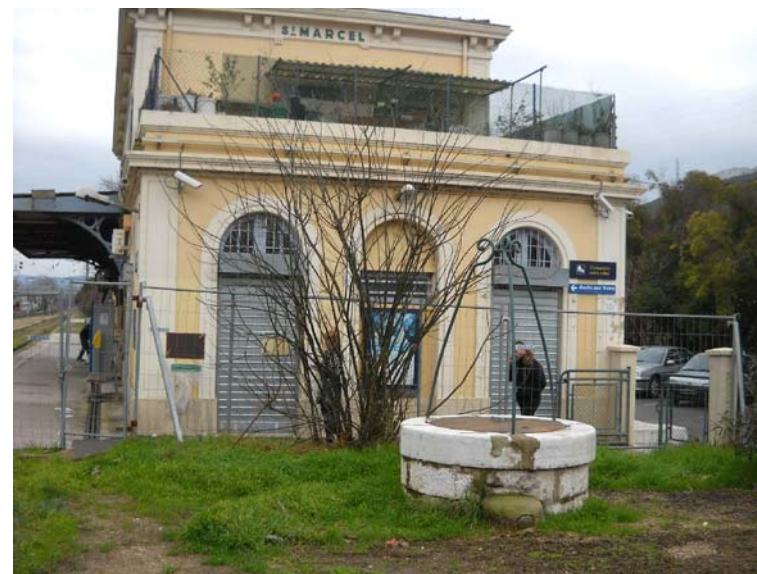
4 - Pignon ouest du BV
