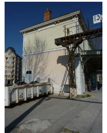
02 - pignon sud BV
