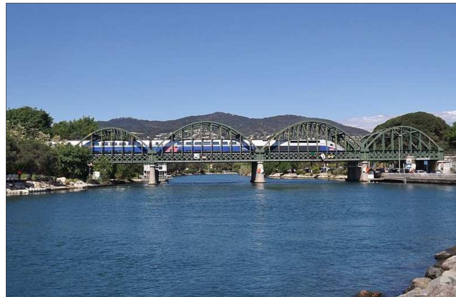
Viaduc de la SIAGNE en exploitation
