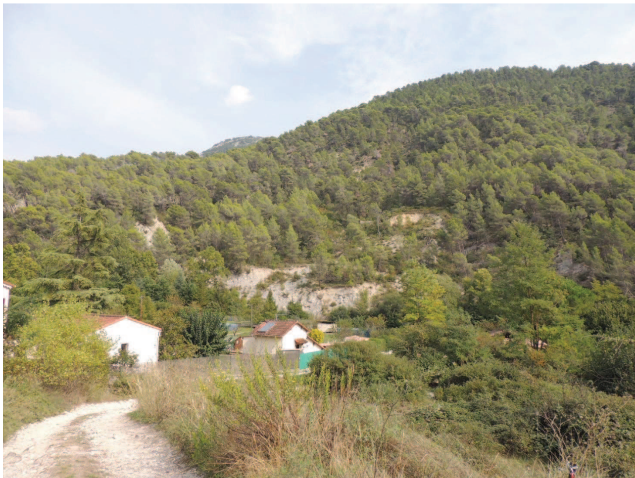
Illustration 13 : vue sur le glissement du versant depuis le chemin des Bouisses en 2012 (Source : Systra, 2012)
