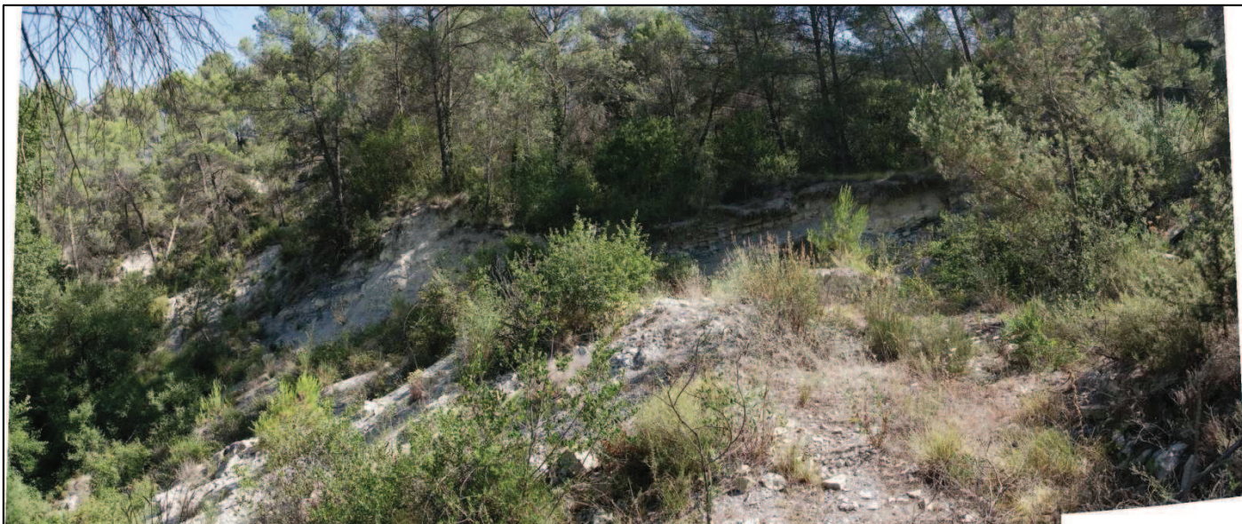
Photographie 25 – Escarpement latéral en limite du glissement côté nord
