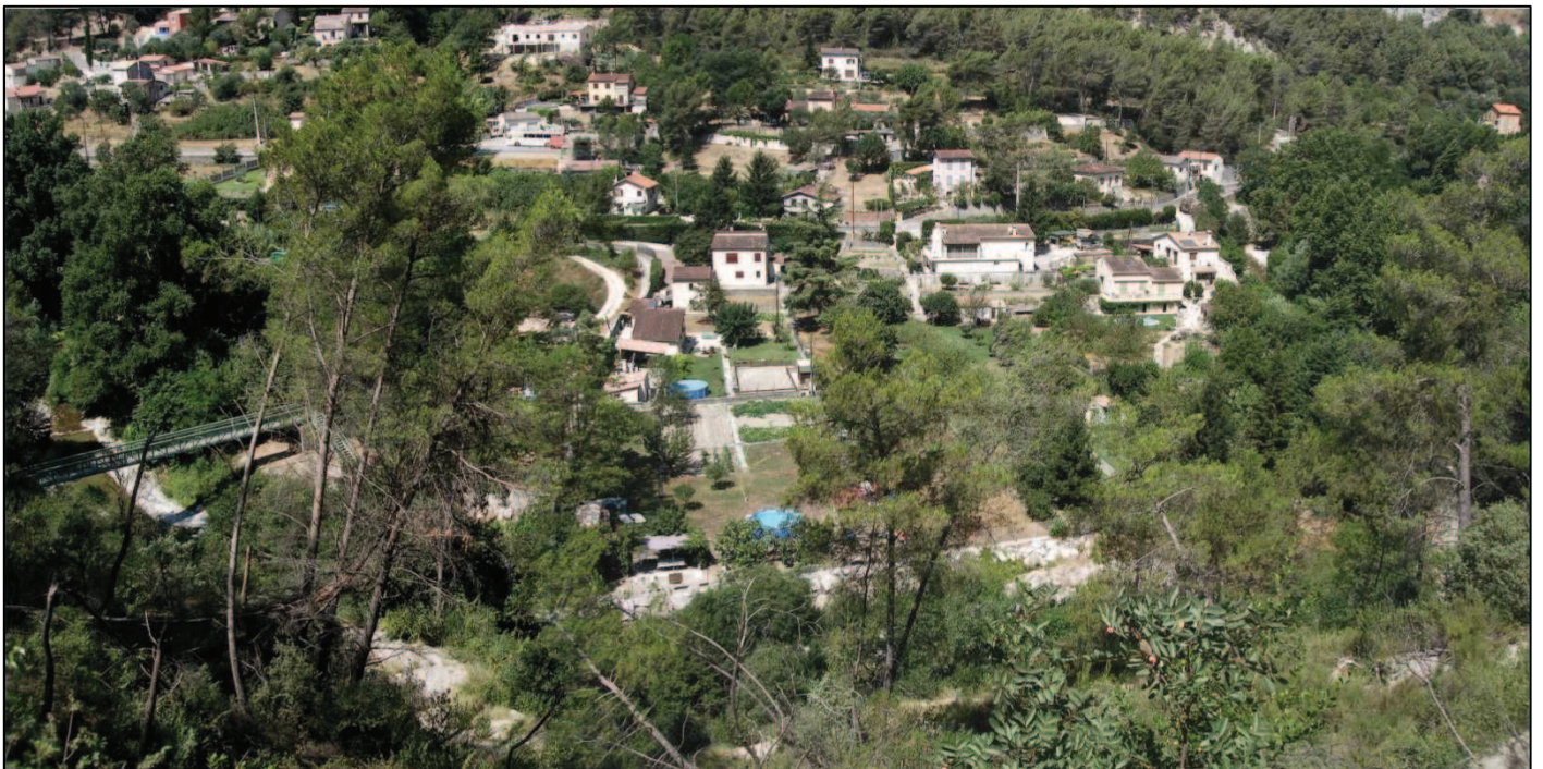
Photographie 28 – Partie aval du versant – Arbres inclinés liés aux instabilités de surface
