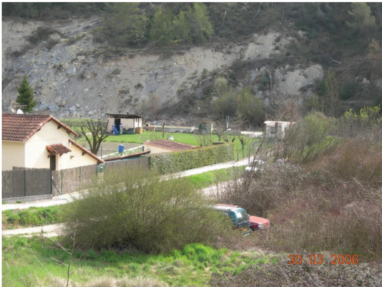
Illustration 12 : vue sur le glissement du versant depuis le chemin des Bouisses en 2006 (Source : CETE, 2011)
