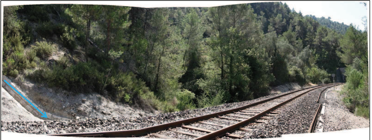
Photographie 35 – PK 15.920 environ - Vue du remblai ferroviaire vers Nice
