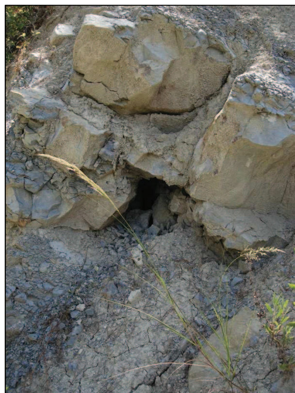
Photographie 24 – Vide dans les affleurements marno-calcaires remaniés
