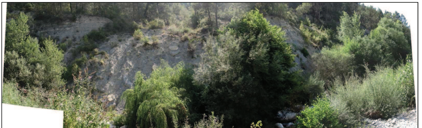
Photographie 8 – Escarpement frontal du glissement de versant en rive droite
