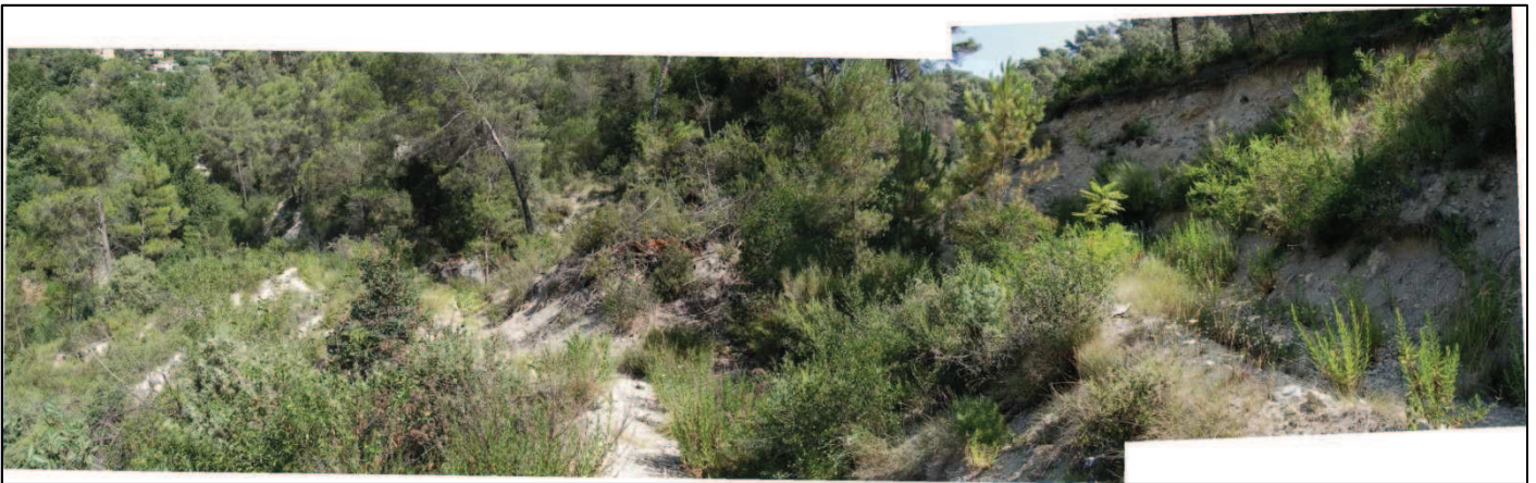
Photographie 19 – Escarpements à droite liés à la réalisation d'un sentier d'accès au tunnel ferroviaire situé en amont
