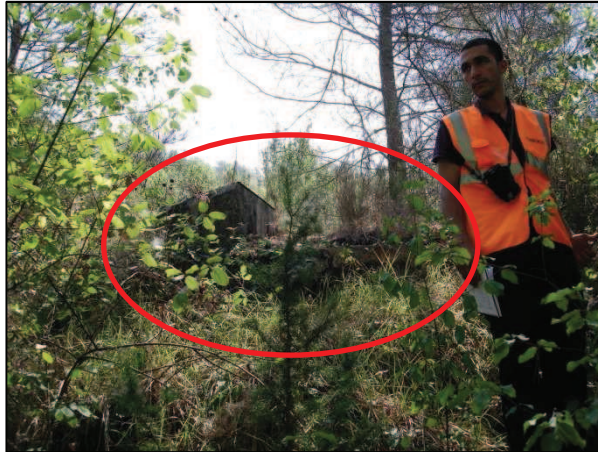
Photographie 41 – Réservoir semi-enterré non répertorié – Toujours en activité
