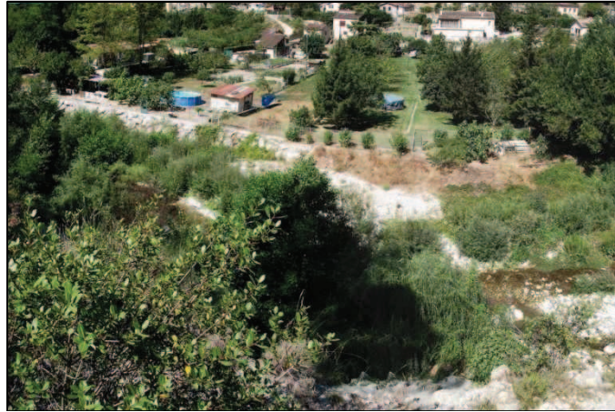
Photographie 18 – Vue de la rive droite et de l'énrochement en limite de parcelle BIANCHERI
