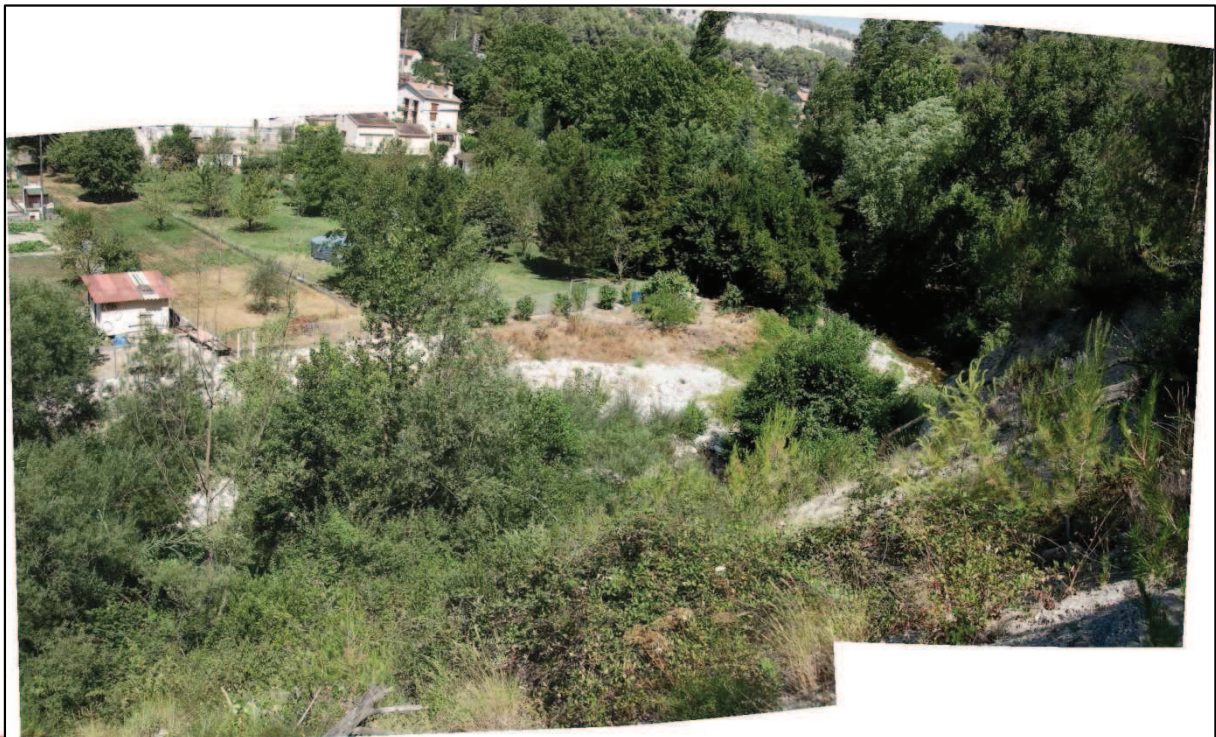
Photographie 20 – Limite amont de la rive droite – Zone végétalisée marron correspondant à des dépôts anthropiques dans le lit du cours d'eau
