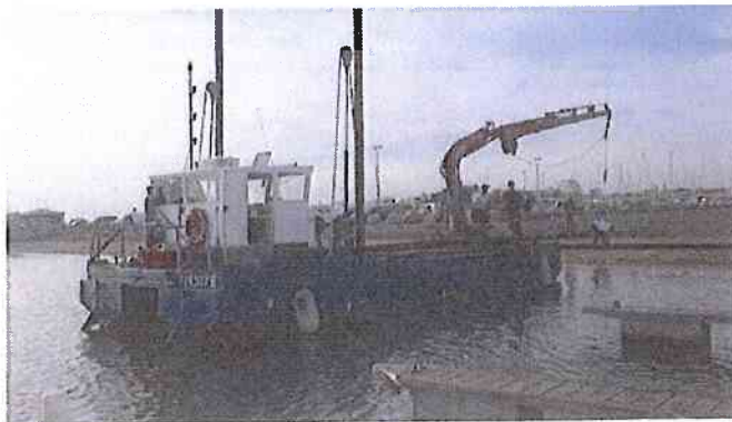
Figure 13- Barge motorisée équipée d'un bras de levage
