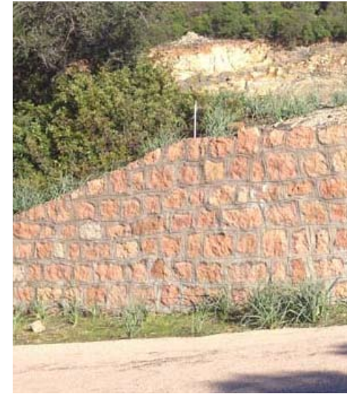
Mur de soutènement en pierres
