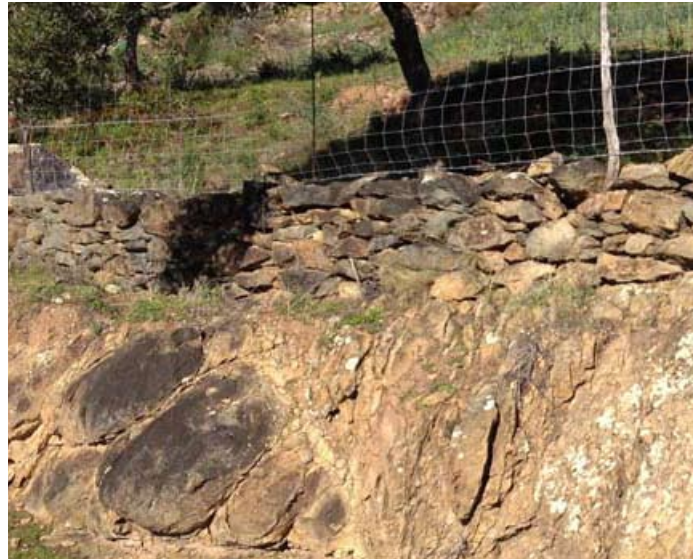
Muret en pierres épousant le talus rocheux
