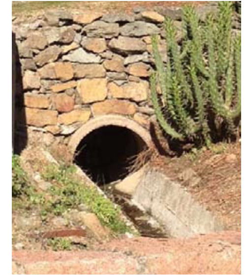
Soutènement en pierres sur buse
