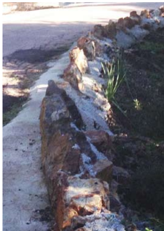
Pierres dressées maçonnées
