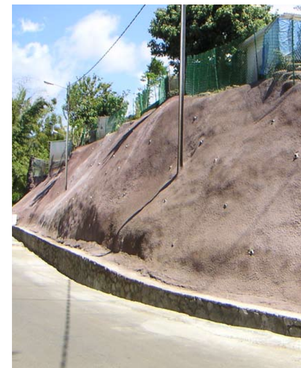
Béton projeté sur talus
