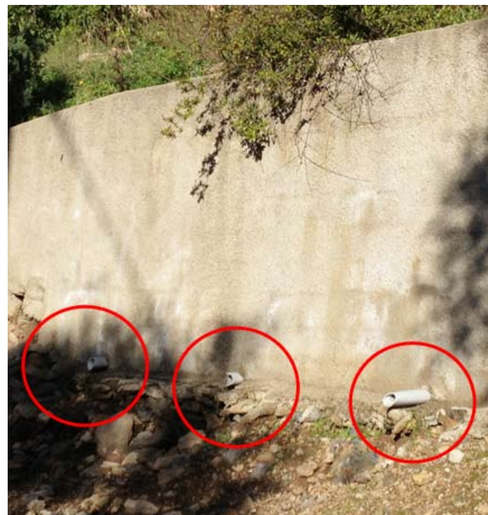
Soutènement en béton et barbacanes en pvc
