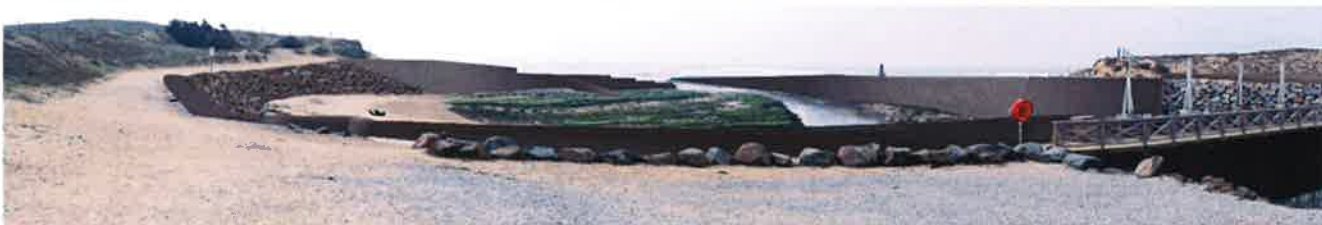
Vue de l'ouvrage depuis la zone de stationnement en amont immédiat du barrage avant et après travaux
