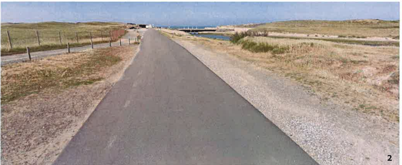
Vues lointaines du barrage depuis la route des Granges
