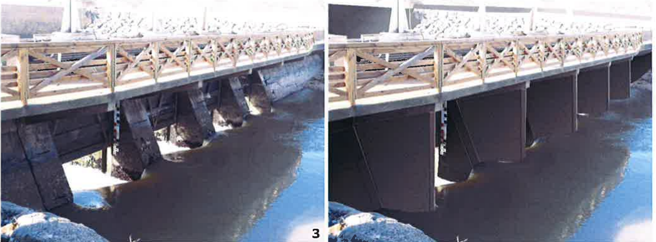
Vues des ouvrages de maintien de la passerelle actuels (à gauche) et projetés (à droite photomontage)
