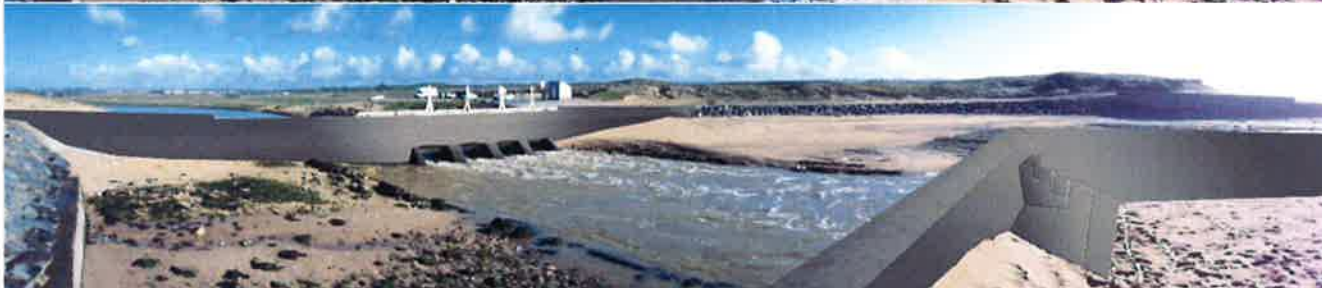
Vue du barrage et du perré Sud depuis le haut du perré Nord avant et après travaux
