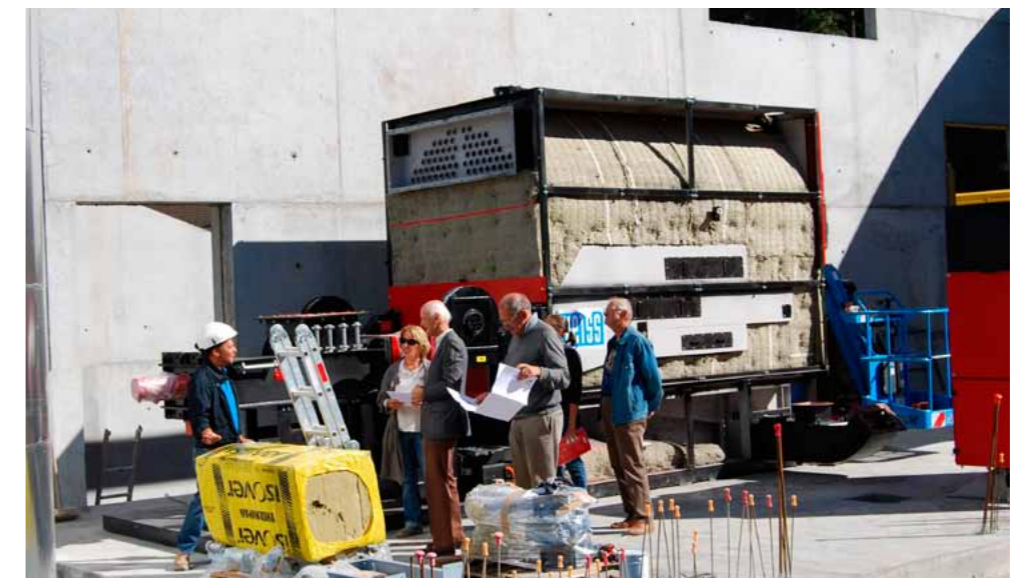
Suivi de travaux, chaudière du réseau chaleur bois. © Mairie.
