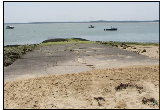
Ancienne cale d'accès (crédit photo : © Crocean, 2010)
