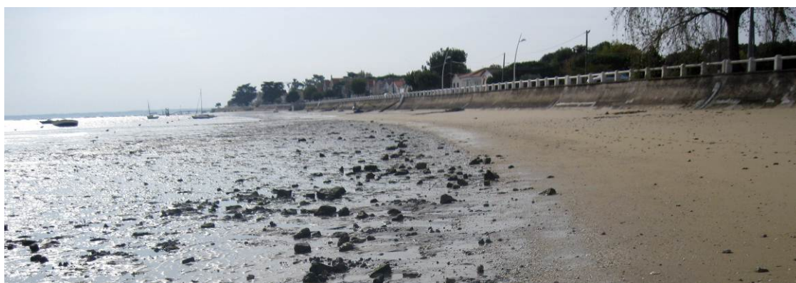
Photo 2 - Prise de vue du haut de plage et du mur de protection béton depuis la digue devant Les Cleunes, quelques bateaux au mouillage sur le site de Petite Plage à gauche (CREOCEAN, 2010)
