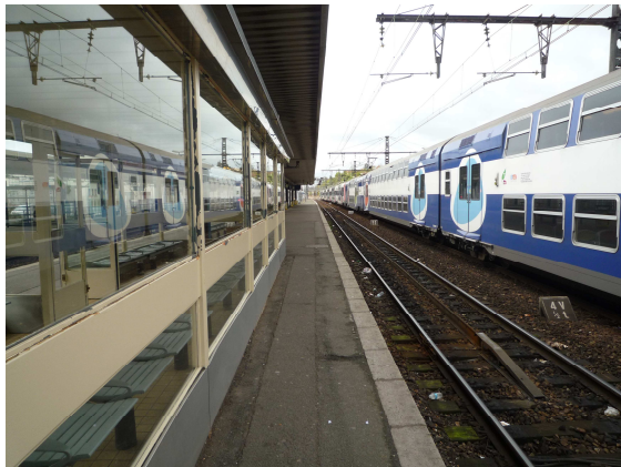
- Photo N°7 : Quai 2 en direction du Sud - (Projet : Vue sur la future passerelle assurant la liaison ville – ville et les ascenseurs liés)
