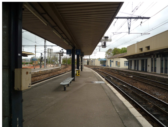
- Photo N°3 : Quai 2 en direction du Nord -
