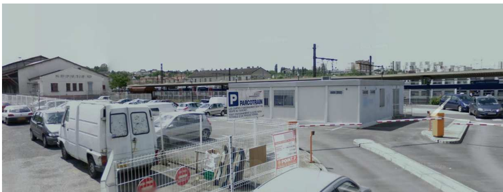
- Photo N°10 : Vue depuis le parking sur les quais - (Projet : Vue sur la future passerelle)
