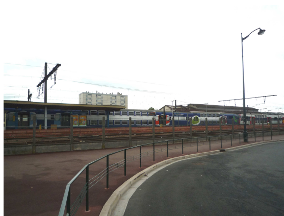
- Photo N°4 : Vue sur les quais de la gare depuis la gare routière Emile Zola -
