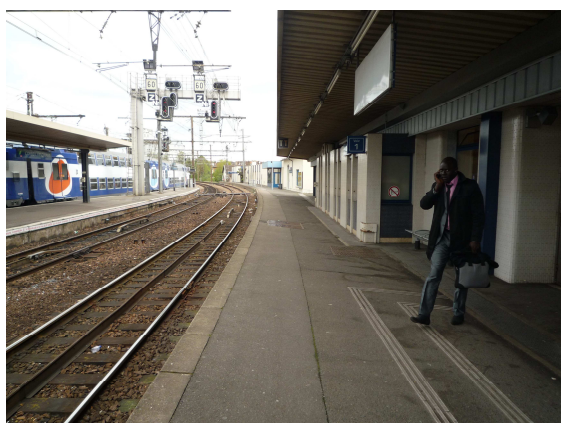
- Photo N°2 : Quai 1 en direction du Nord au niveau du Bâtiment Voyageurs -
