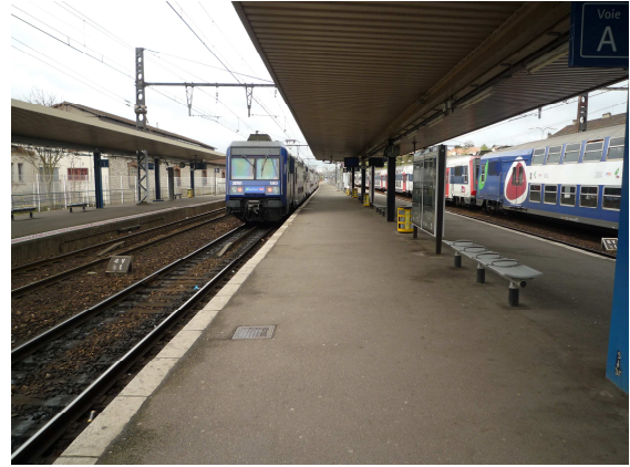
- Photo N°8 : Quai 2 en direction du Sud - (Projet : Vue au niveau de l'implantation de la future passerelle assurant la liaison ville – ville)
