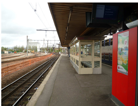
- Photo N°5 : Quai 3 en direction du Nord -
