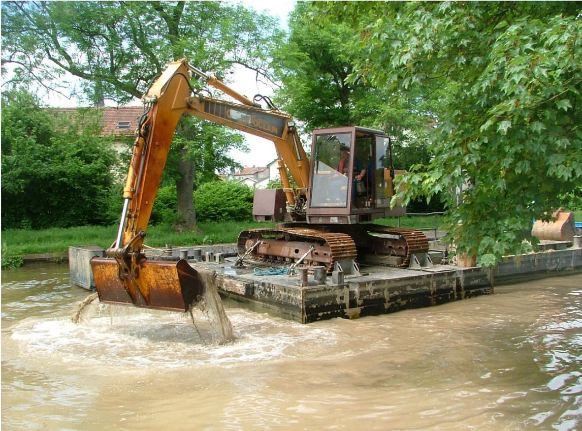
Figure n°F5\_4 : Nuage de sédiments autour de la pelle sur ponton sur le canal des Vosges (2000, Direction du nord – est VNF),
