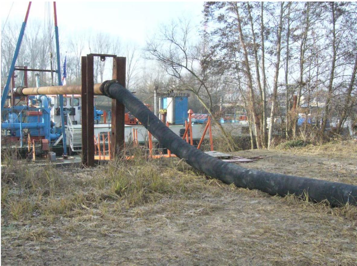
Figure n°F4.1\_2 : transport de sédiments par barge sur l'Oise, par conduite pour le déchargement de barges vers une gravière (2010, DIR de la Seine VNF)
