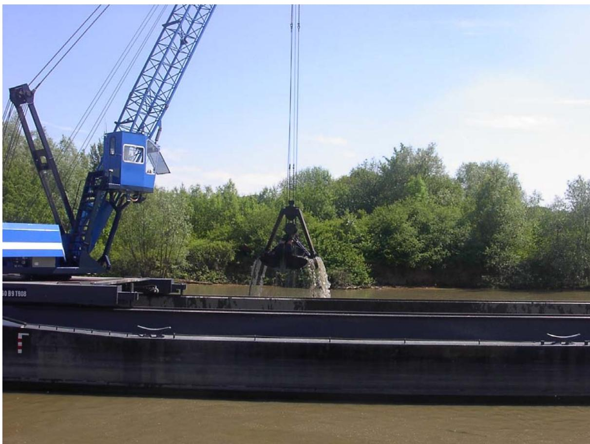
Figure n° F 4.1\_0 : dragage mécanique réalisé sur la Moselle (2002, DIR Nord-Est, VNF)
