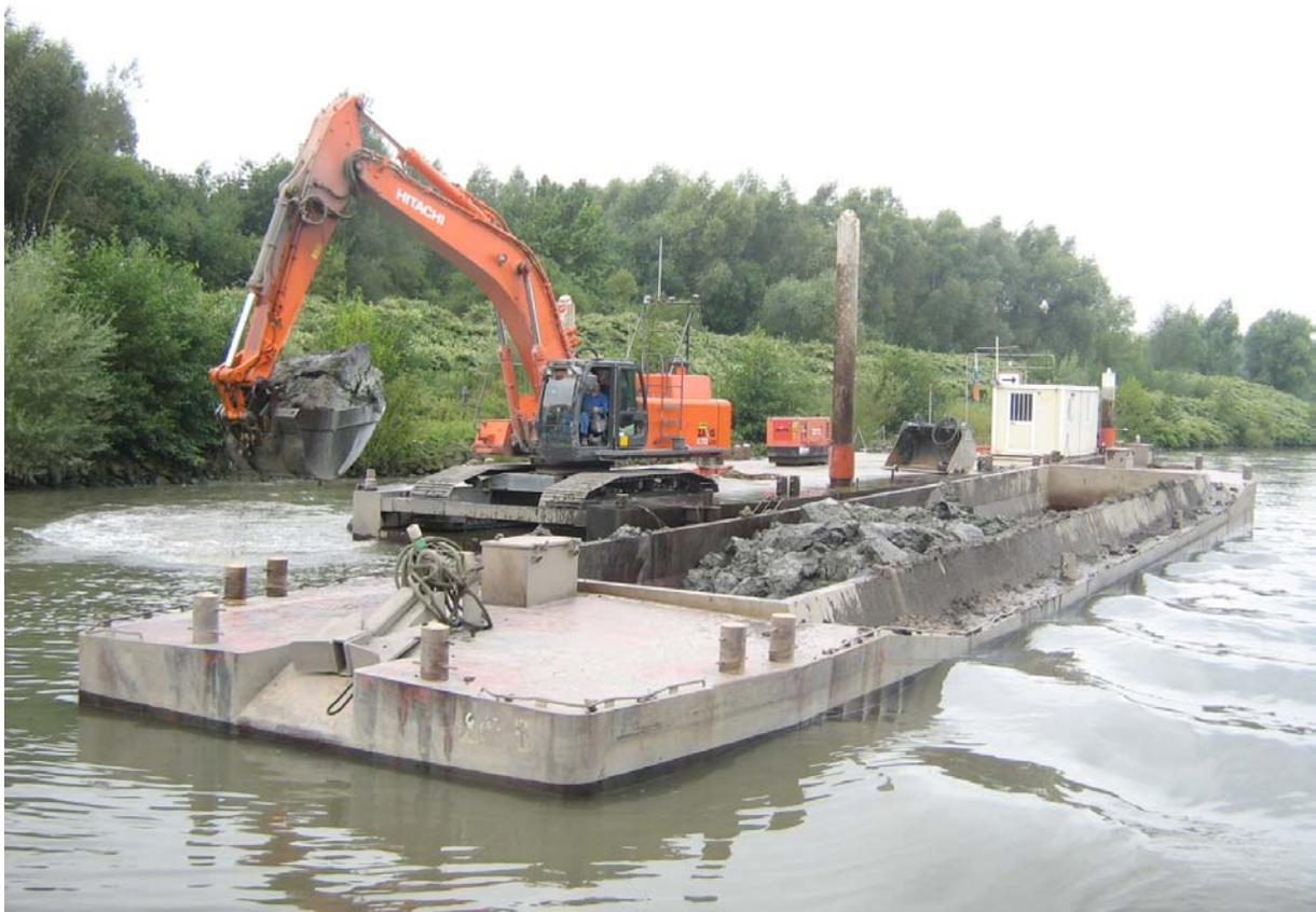
Figure n°F0\_1 : Dragage mécanique sur l'Escaut
