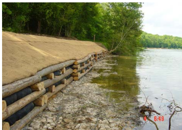
Illustration 47 : Protection de berge de la Saône à Autet par caissons et matelas gabions [Source VNF]
