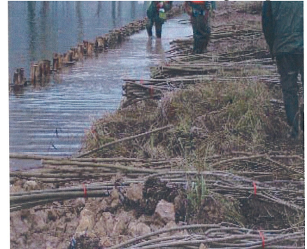
Illustration 20 : Fagots pour le tressage [Source VNF]
