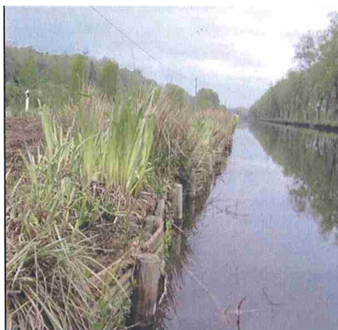
Illustration 24 : Vue de la fin des travaux [Source VNF]
