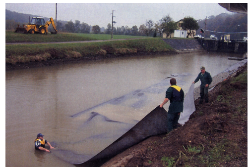
Illustration 59 : Mise en œuvre de la protection dans le canal en eau [Source VNF]
