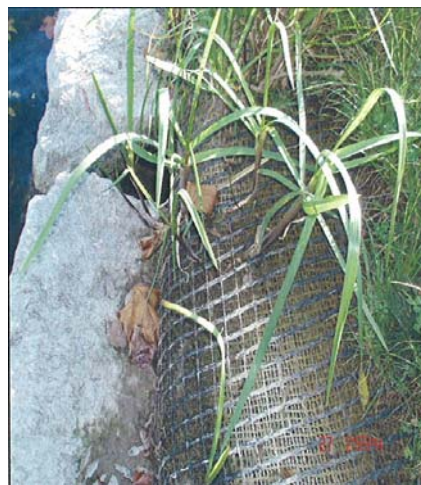
Illustration 46 : Vue détaillée du géogridde [Source VNF]
