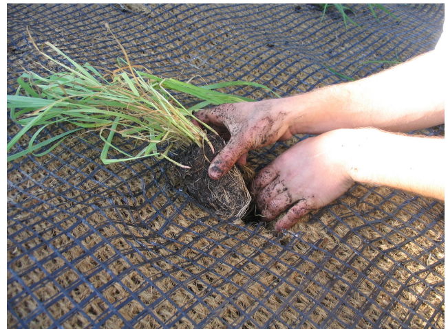
Illustration 61 : Plantation d'un boudin à Montigny sur Meuse [Source VNF]
