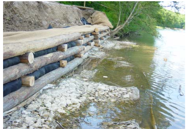
Illustration 49 : Mise en œuvre des caissons au-dessus du matelas gabion [Source VNF]
