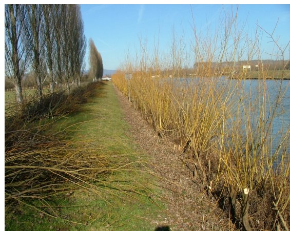
Illustration 13 : Protection de berge par double rang de tressage [Source CETE de Lyon]
