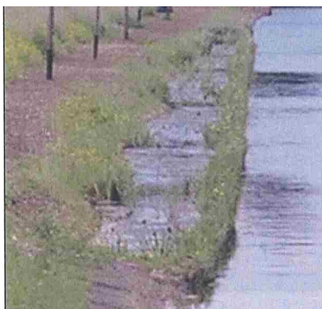
Illustration 27 : Vue après travaux [Source VNF]
