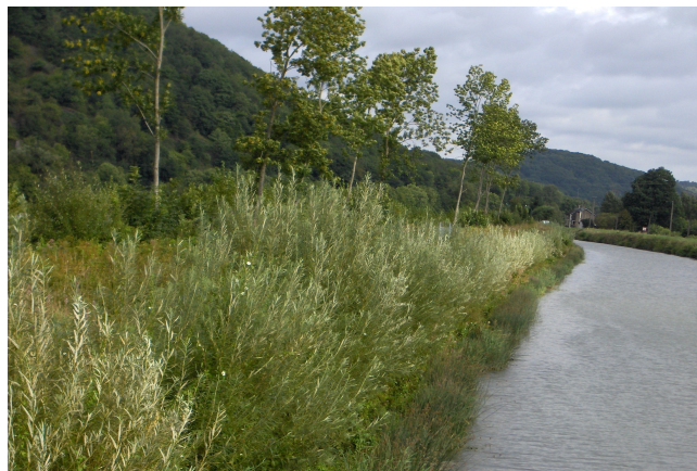
Illustration 42 : Vue de la berge en 2008 [Source CETMEF]
