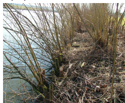
Illustration 15 : Le tressage nécessite un recépage régulier [Source CETE Lyon]
