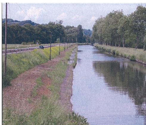
Illustration 32 : Fin des travaux [Source VNF]
