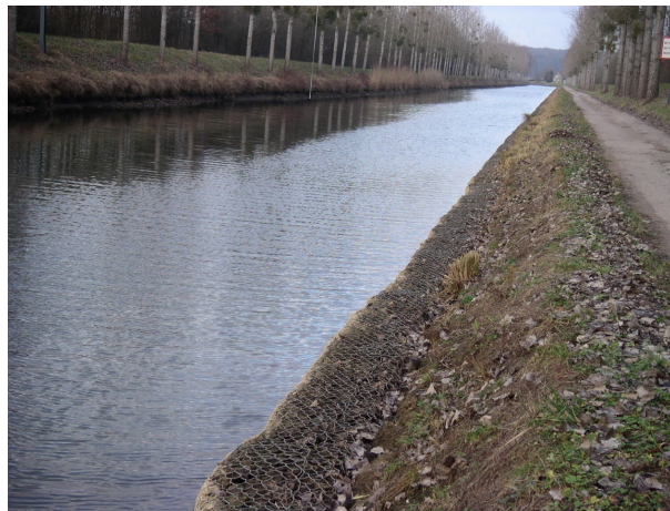
Illustration 1 : Protection par cages gabions et fascines d'hélophytes (décembre 2007) [Source CETE de Lyon]
