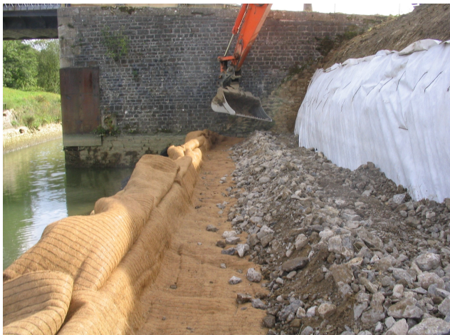
Illustration 60 : Mise en place d'un boudin à Montigny sur Meuse [Source VNF]
