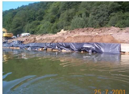
Illustration 37 : Coffrage végétal [Source VNF]
