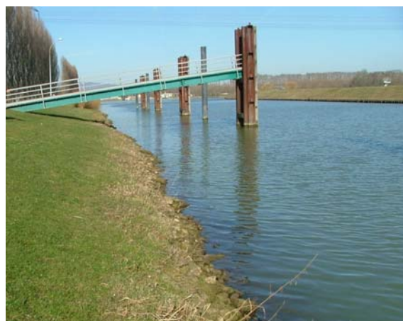
Illustration 50 : Enrochements végétalisés (postes d'attente) [Source CETE de Lyon]
