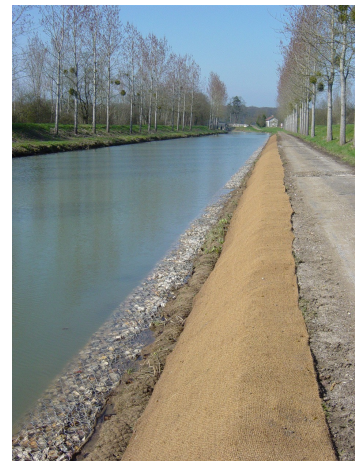
Illustration 56 : Fin des travaux [Source CETE de Lyon]
