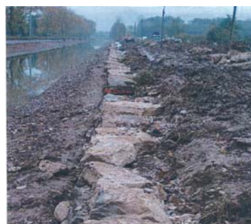
Illustration 44 : Vue des enrochements [Source VNF]
