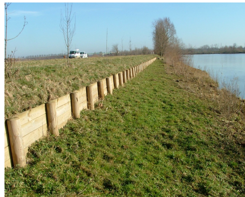
Illustration 34 : Protection par tunage [Source CETE de Lyon]
