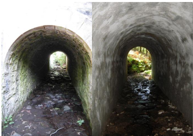
Aqueducs routiers prospectés (présence de chauves-souris recherchée en été)
