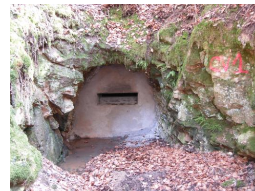
Aménagements de sécurisation minière avec lucarne pour le passage des animaux
