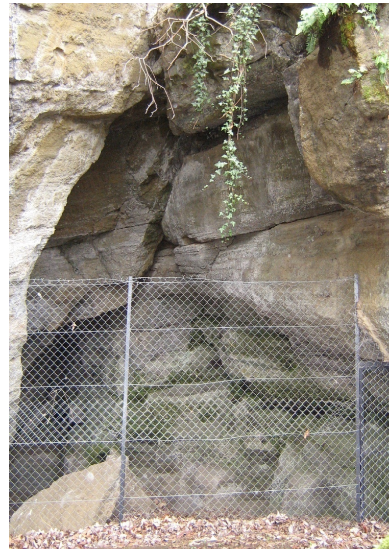
Entrée de la grotte de la Denise après pose du grillage CEPA_Hervé Balmisse ©
