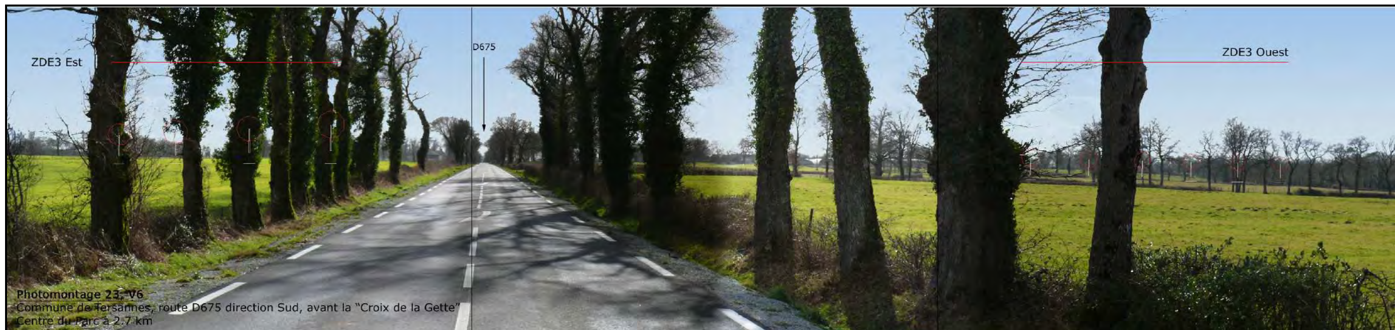
Figure 105 : Vue de la ZDE n°3 depuis Tersannes avant "la croix de la Gette"
