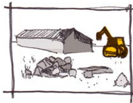
RUINES DE BÂTIMENTS Destruction et nettoyage du site des restes de l'exploitation.
