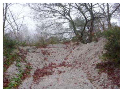
Remblais pour bloquer des accès aux plateformes.
