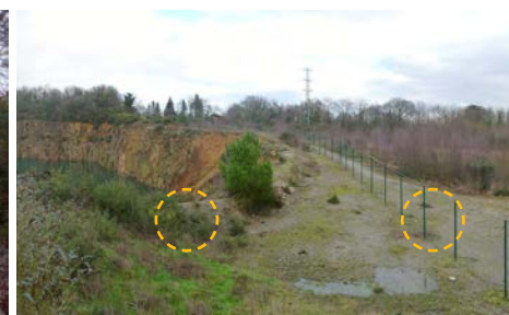
Merlon et clôture pour interdire l'accès au plan d'eau et aux fronts de taille.
