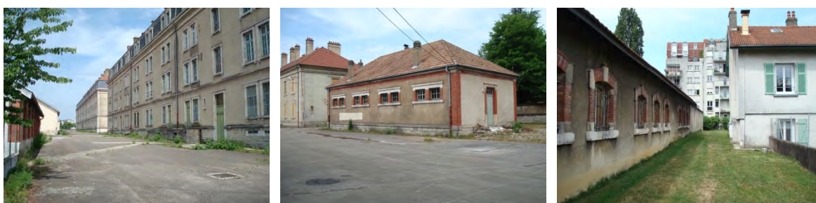
Exemple de bâtiments démolis, MDR (41 et 43), (19) et salle HON et TAC (22)
