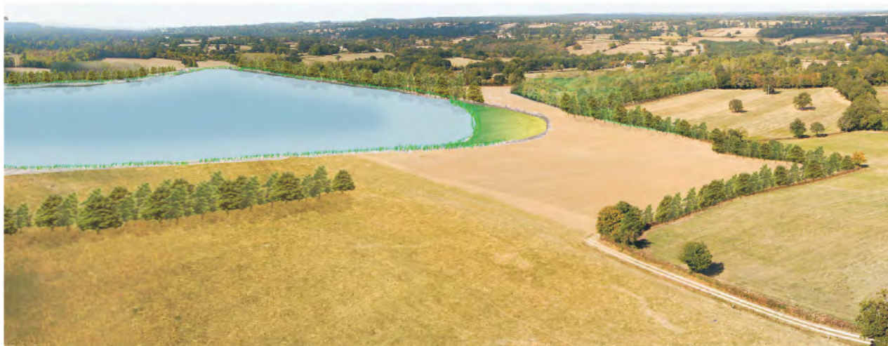
Présentation du site réaménagé (vue aérienne à basse altitude depuis le Sud-Est, aux abords du Mondelet)
