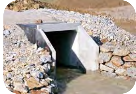
Exemple de buse-dalot à mettre en place
