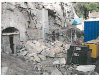
Confortement de falaises à Chars (95)
