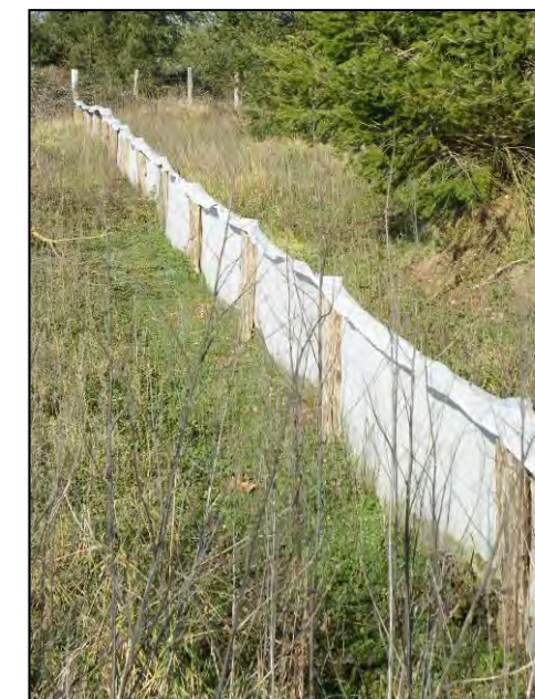
Clôture en géotextile mise en place autour de la mare de Chantalouette
