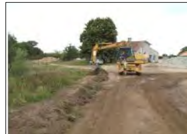
Ouverture de tranchée et pose des piquets pour l'installation du bidim. Crédit Photographique J.-L. Pratz/CIAE
