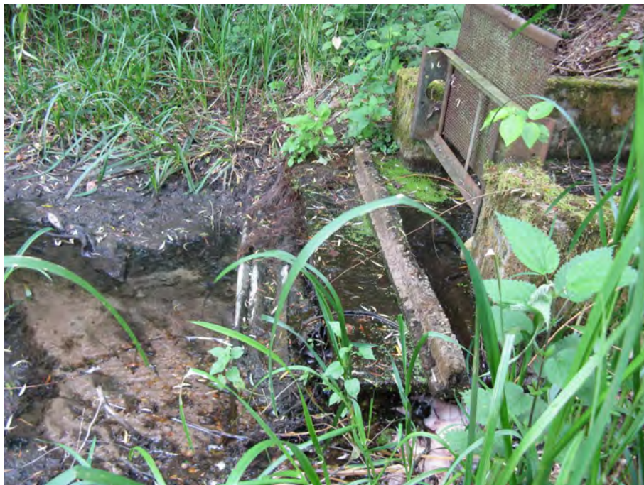
Sortie de l'ouvrage n° 4 de vidange du petit étang dans l'étang Marian
