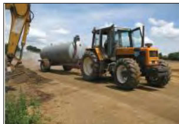
Arrosage des voies de circulation des véhicules de chantier. Crédit photographique J.-L. Pratz/CIAE
