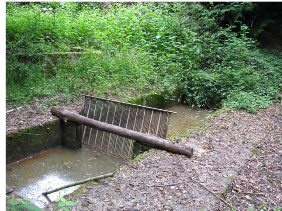
Ouvrage de vidange de l'étang Marian, en aval de la digue
