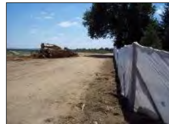
Barrière de protection batraciens et barrière de protection anti-poussières en place. Crédit photographique Benjamin Debail/CIAE
