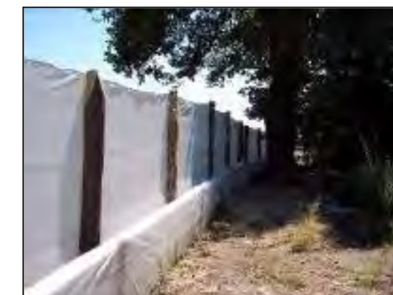
Barrière de protection batraciens et barrière de protection anti-poussières en place. Crédit photographique Benjamin Debail/CIAE
