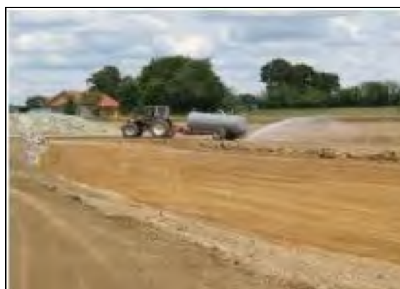
Arrosage des voies de circulation des véhicules de chantier. Crédit photographique J.-L. Pratz/CIAE
