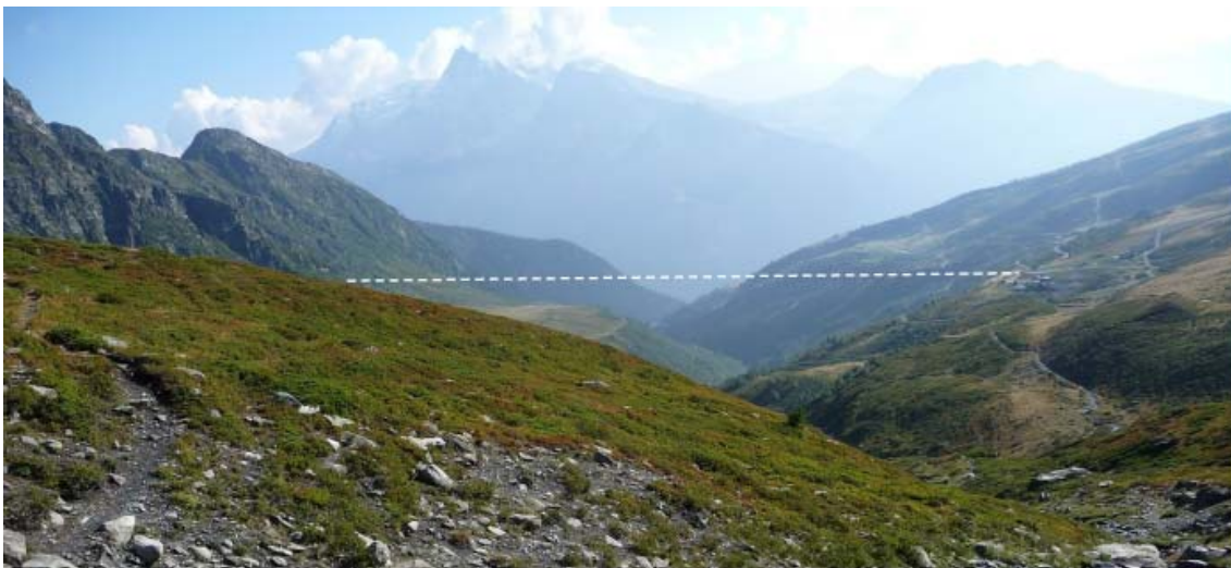
Photo 10 Localisation du câble transporteur de la carrière des Lauzes
