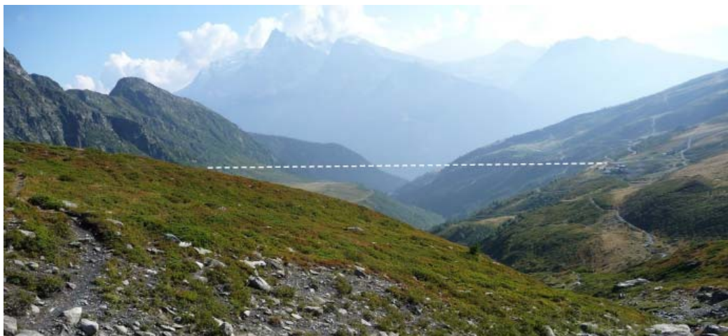
Photo 8 Localisation du câble transporteur de la carrière des Lauzes
