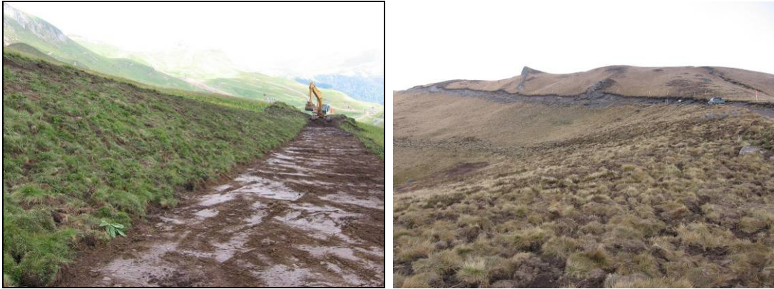
Photo 7 Exemple de chantier de replaquage de mottes Source : Agrestis ©
