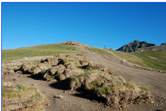
Photo n° 19 : Exemple de déplacement / replacage au Col du Tourmalet (à gauche plaque de pelouse en attente, à droite derrière le bâtiment talus après mise en œuvre)
