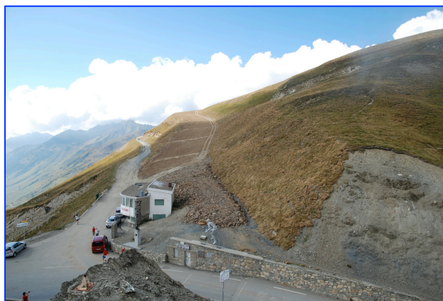
Photo n° 19 : Exemple de déplacement / replacage au Col du Tourmalet (à gauche plaque de pelouse en attente, à droite derrière le bâtiment talus après mise en œuvre)
