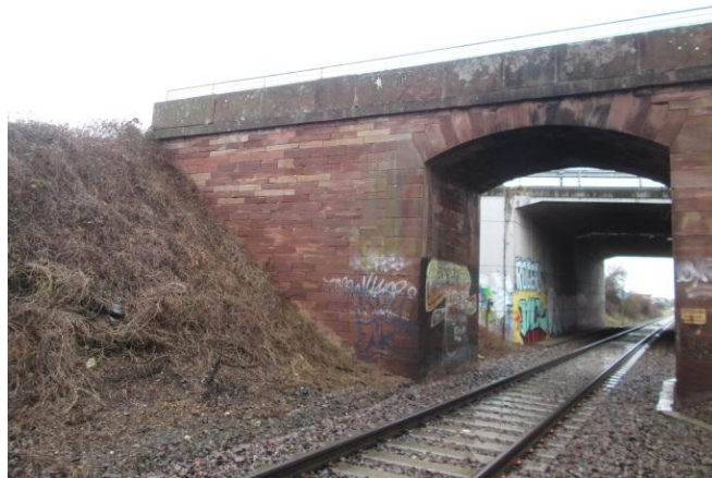
Fig. 6. Vue du PRO km 31+319
