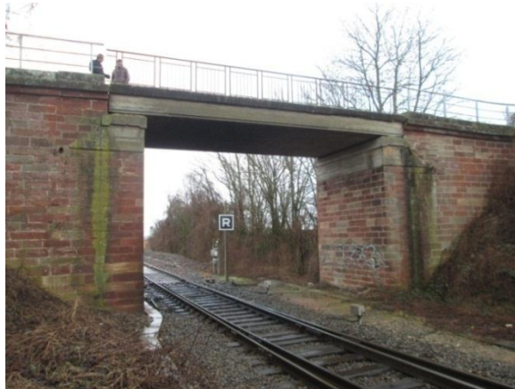
Fig. 5. Vue du PRO km 30+319
