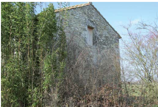
Num de la photo : 2927 Petit bâtiment implanté sur la limite nord du site dans le site, bouquet de bambou
