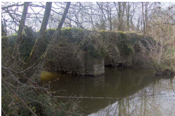
Num de la photo : 3547 Pont ancien à trois arches, limite sud de l'étang et limite sud-ouest du site
