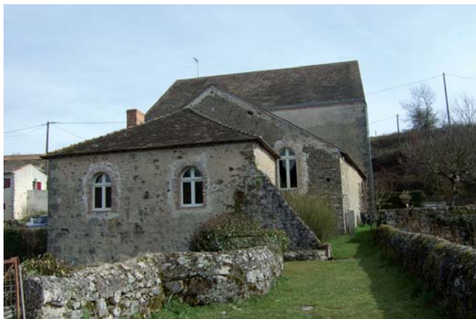
Num de la photo : 4557 Bâtiment de la Forge, vue depuis l'ouest, propriété privée restaurée et transformée en restaurant par les nouveaux propriétaires
