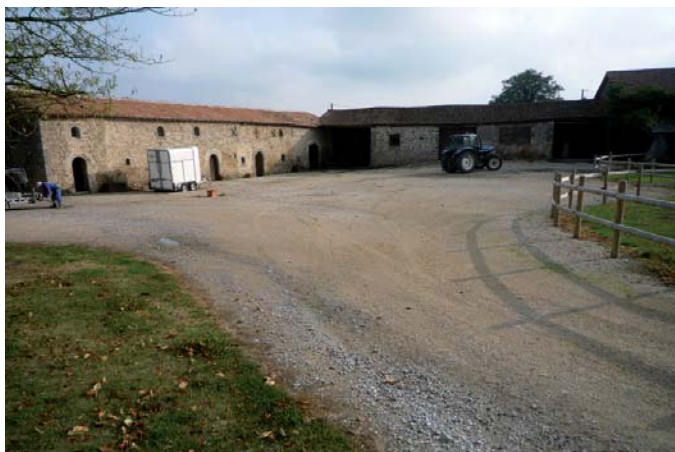
Num de la photo : 164 Cour des communs, ancienne enceinte
