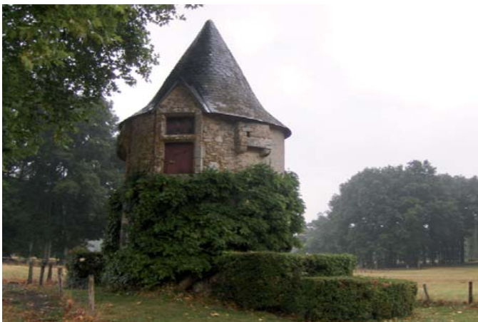
Num de la photo: 6173 Ancienne tour à l'angle sud-est de la cour
