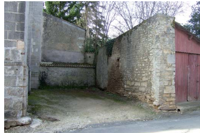
Num de la photo: 4297 Terrain vide en site, garage en site, le toit est au niveau du terrain. Vue sur le pignon de la sacristie.
