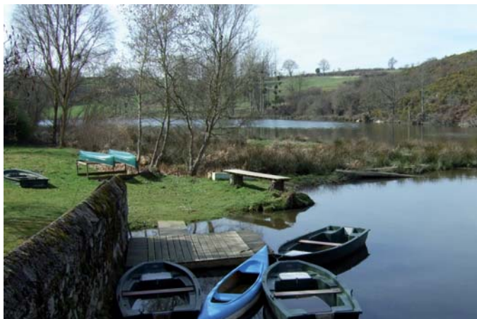
Num de la photo : 4550 Etendue d'eau en amont de la digue. Ponton et espace occupé par des barques. Rive droite du Thouet
