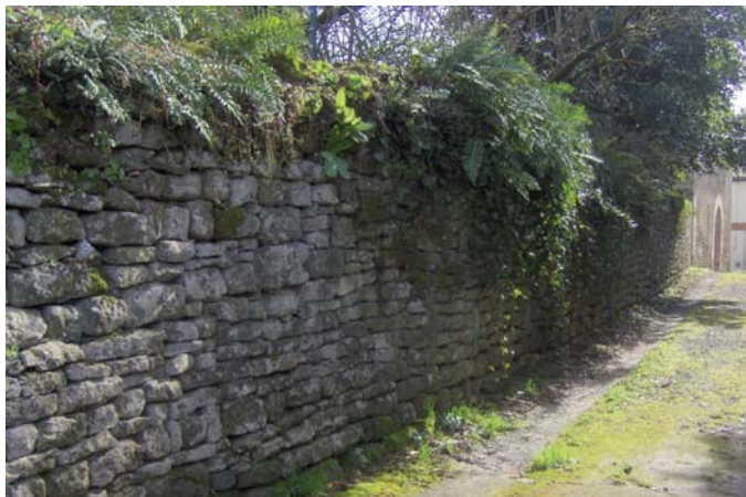
Num de la photo: 3333 Mur d'enclos en bordure ouest du site, surmonté de lierre et de fougère, vu depuis l'espace public
