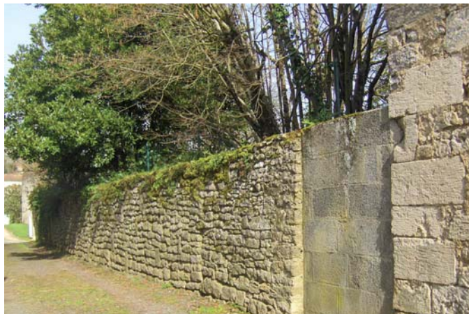
Num de la photo: 3335 Mur d'enclos en bordure ouest du site, surmonté de lierre et de fougère. A l'extrémité, contre l'église, ancienne porte murée
