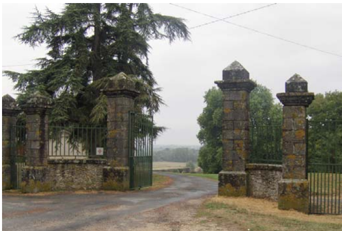
Num de la photo: 6221 Portail monumental à l'entrée sud-est
