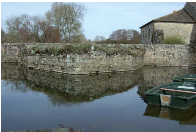
Num de la photo : 4552 Ouvrage hydraulique bâti en forme d'étrave pour limiter la poussée des embâcles contre la digue
