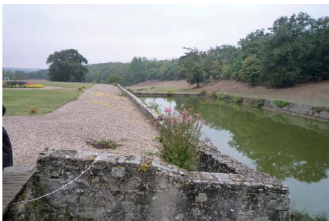
Num de la photo: 089 Angle sud-ouest du bassin en contact avec la terrasse
