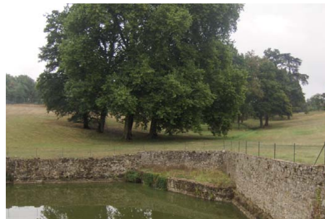
Num de la photo: 6239 Angle sud-est du bassin
