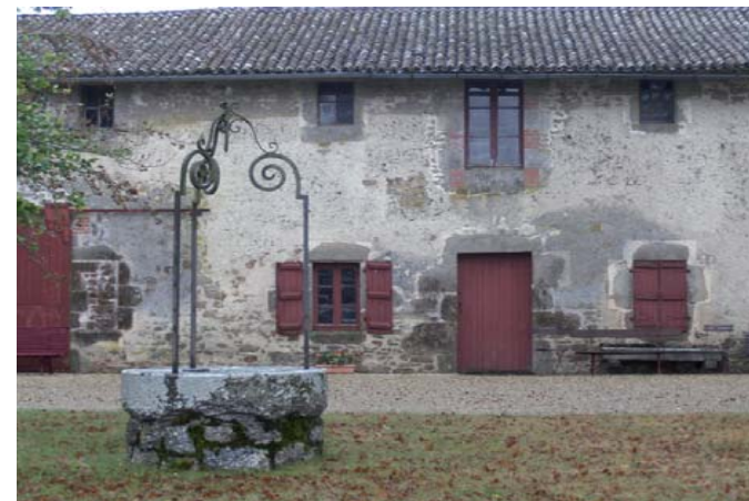
Num de la photo: 6174 Façade sur cour des communs
