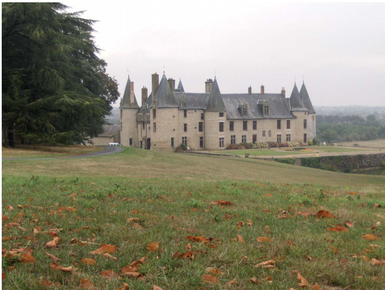
Vue d'ensemble en arrivant par l'entrée située au sud-est. (photo 6626)
