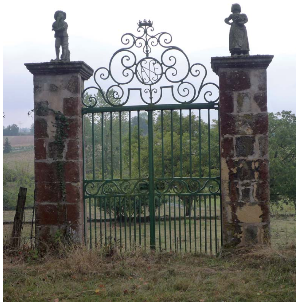
Num de la photo : 09 105 Portail d'entrée vers l'ancien potager
