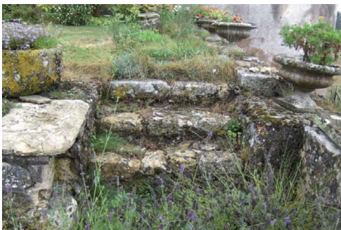
Num de la photo: 6246 Petit escalier de rattrapage de niveau sur la terrasse
