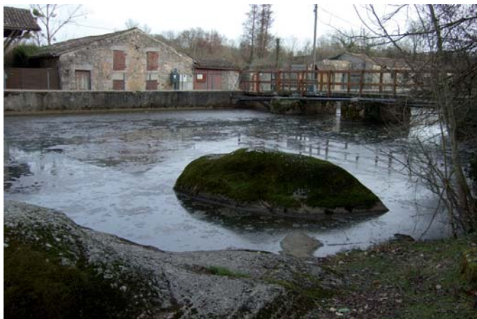
Num de la photo : 4381 Passerelle reliant le hameau et la presqu'île du donjon
