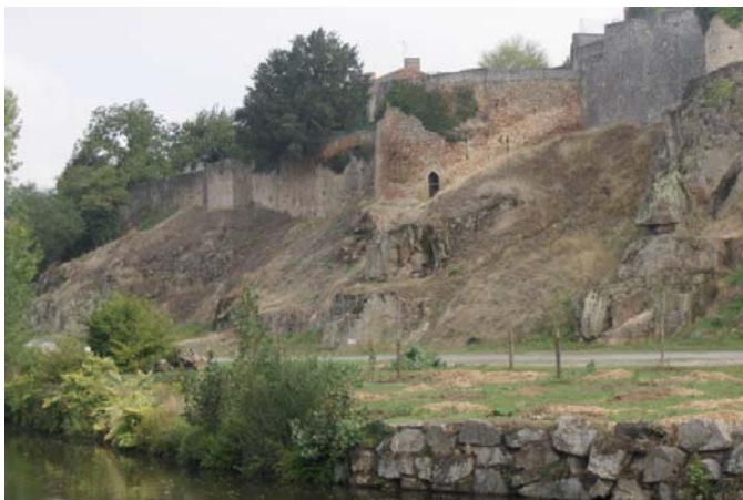
Num de la photo : 6324 Versant ouest, dégagement de la végétation qui favorise la lecture des murailles et restauration des maçonneries.
