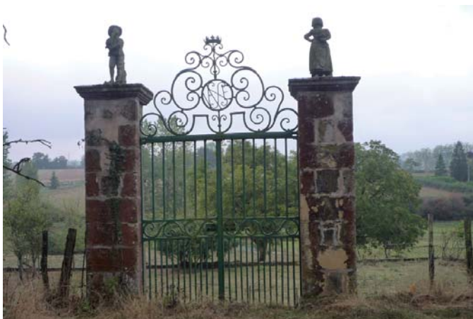
Num de la photo: 105 Jeu de terrasse, au sud du château. Portail situé entre les deux niveaux de terrasse
