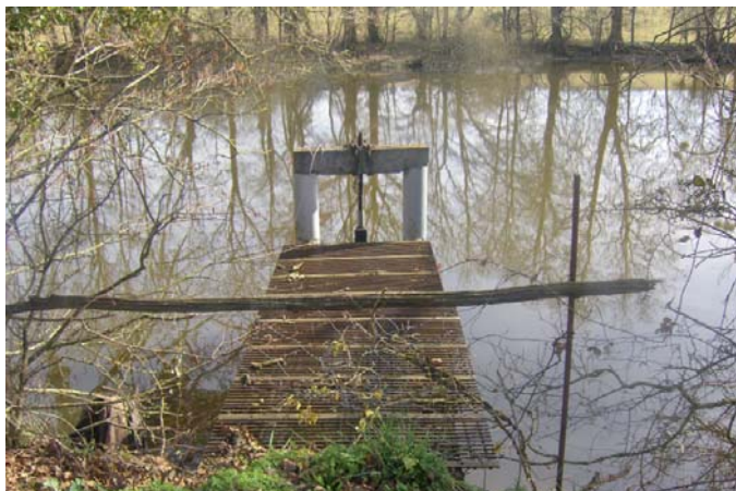
Num de la photo : 3524 Ponton sur l'étang et système hydraulique pour le passage de l'eau sous la route/digue
