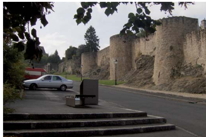
Num de la photo : 6399 Vue d'ensemble du flanc orienté ouest.
