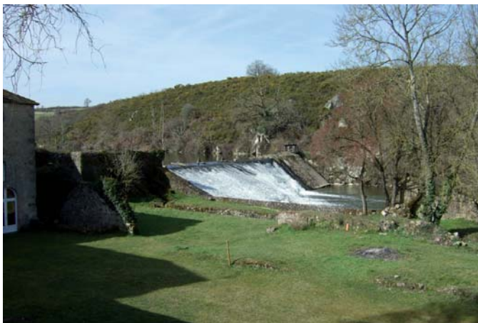
Num de la photo : 4523 Chaussée en travers du Thouet et ouvrages hydrauliques de la forge
