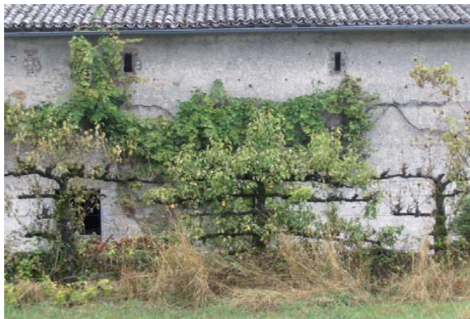
Num de la photo: 6204 Conduite en espaliers
