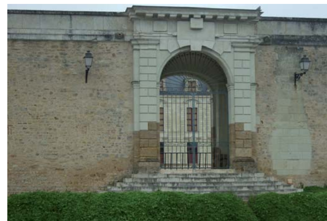
Num de la photo : 4768 Entrée exposée ouest, cour du château de Tremoille
