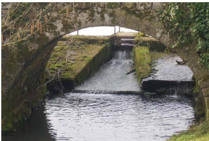
Num de la photo : 3378 Zoom sur le déversoir entre les arcades du vieux pont
