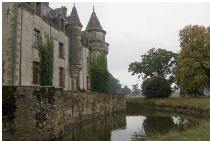
Num de la photo: 6179 Façade sud du château avec pont de franchissement des douves
