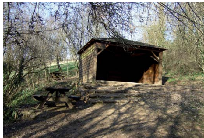
Num de la photo: 4150 Préau en bois (abris) et tables de pique-nique en bordure du ruisseau, à proximité de la passerelle
