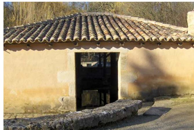
Num de la photo: 3059 Lavoir du Loubeau, hors site
