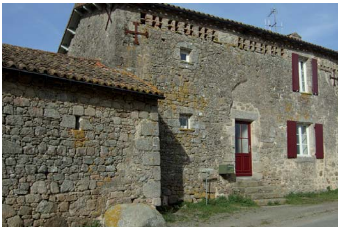
Num de la photo : 4566 Logis des Seigneurs du pont d'Hérison ; ouvertures pour les pigeons sous le toit
