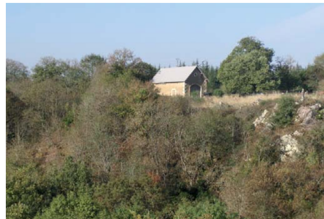
Num de la photo : 6463 Bâtiment dépendant de la Chaise, en bordure de site en rebord de plateau côté nord
