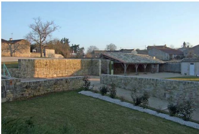
Num de la photo: 4031 Vue depuis le site vers l'est, vers l'espace aménagé aux abords du préau (hors site)
