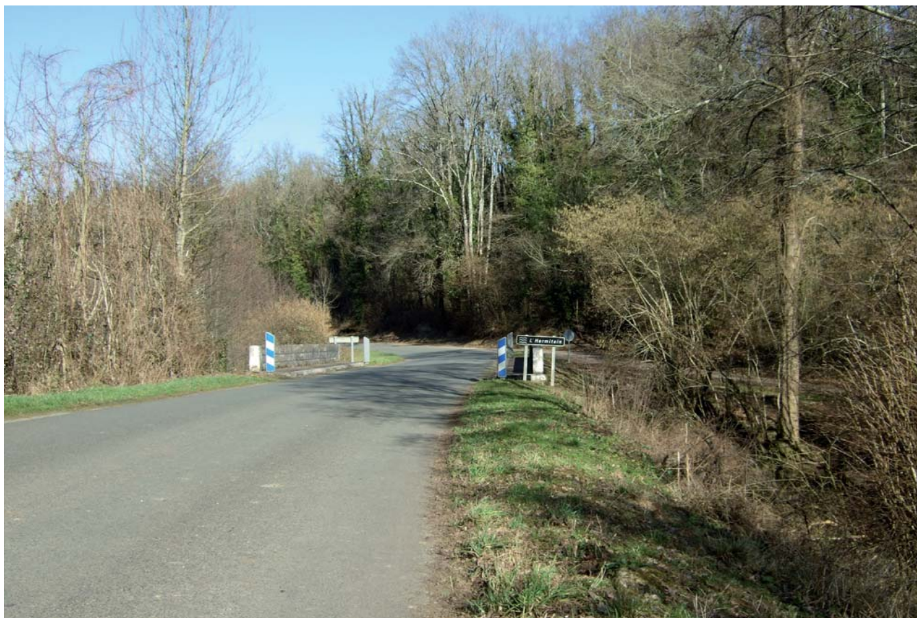
Pont de la RD 124 sur le ruisseau de l'Hermitain, à quelques dizaines de mètres du périmètre du site classé (photo 4105)
