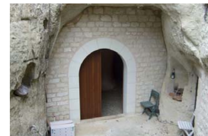
Entrée de la salle (extérieur) (photo 4861)
