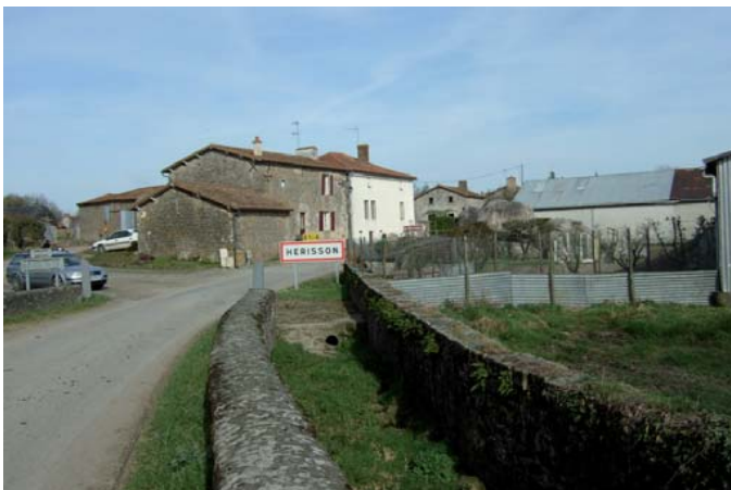
Num de la photo : 4576 Entrée du village, vue vers le logis des seigneurs du pont d'Hérison en face de la Merveille
