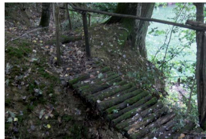
Num de la photo : 6293 Détail du cheminement, passerelle en rondin
