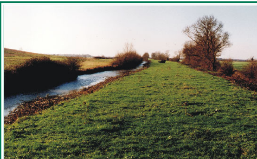
La levée des Arceaux au pied de la butte de Flay, préservée et garantissant la continuité hydraulique
