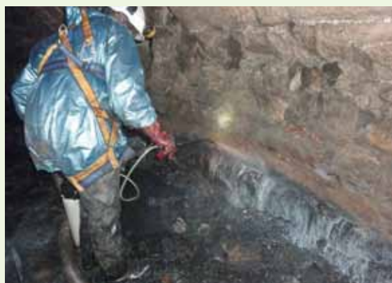
Nettoyage de la galerie souterraine (source Ademe)
