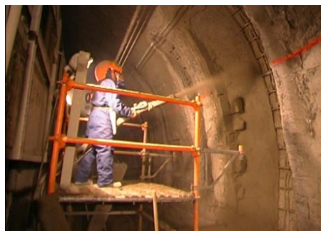
Photo n°7 : Projection de béton en galerie (source : http://www.planete-tp.com )
