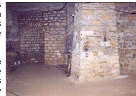
Photo n°6 : Consolidation par piliers maçonnés (carrière de la Brasserie, Vincennes)
