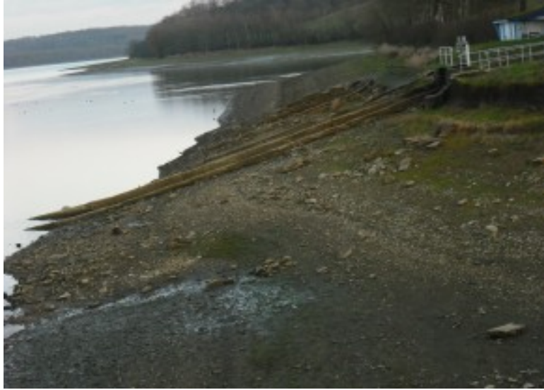
Barrage de La Liez digue secondaire
