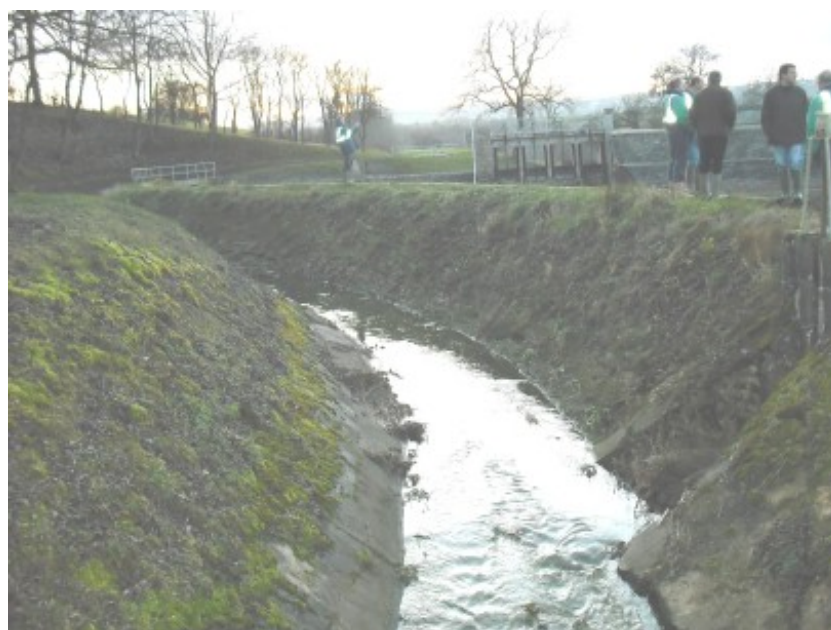
Barrage de La Liez Rigole de Vaucouleurs
