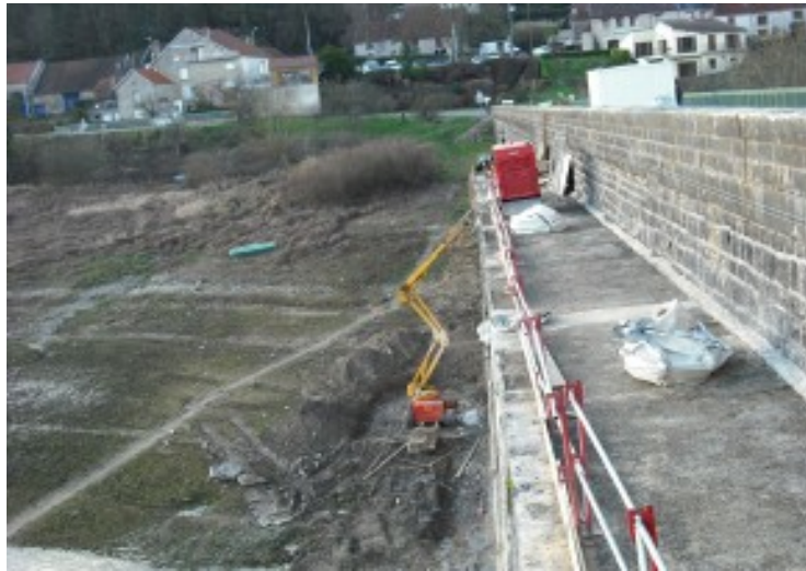
Barrage de La Mouche vue du parement amont
